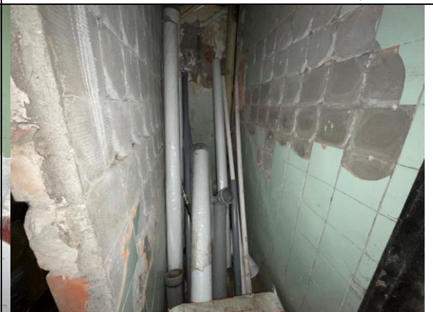
Фото 26. Типичное состояние Объекта оценки
