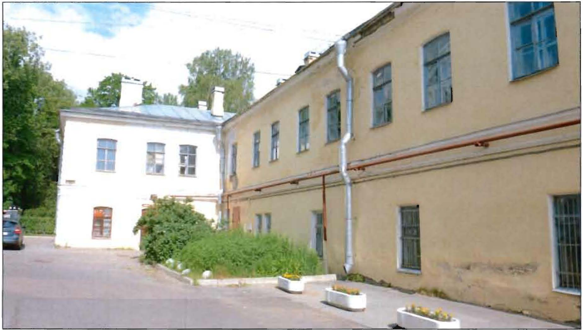
5. Северо-западная часть здания. Вид с юго-востока.
