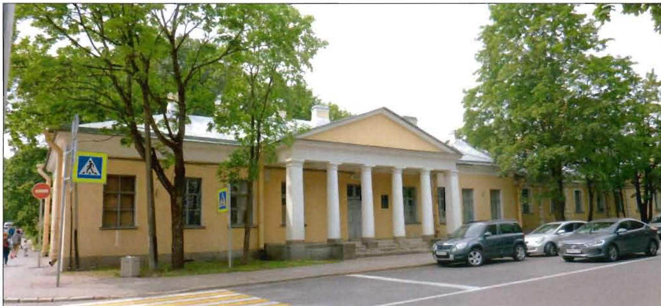
1. Восточная часть здания. Вид с востока.
