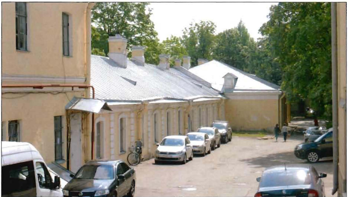
6. Восточная часть здания. Вид с запада.
