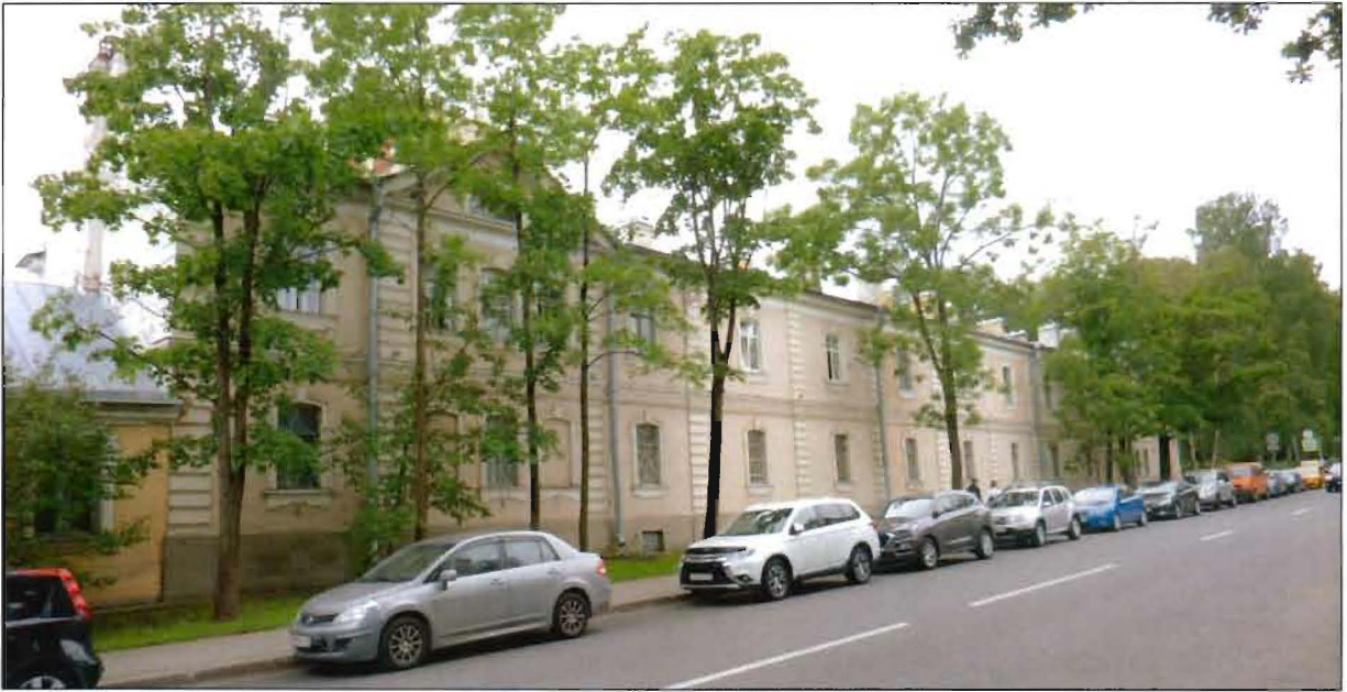
3. Северный фасад. Вид с востока.
