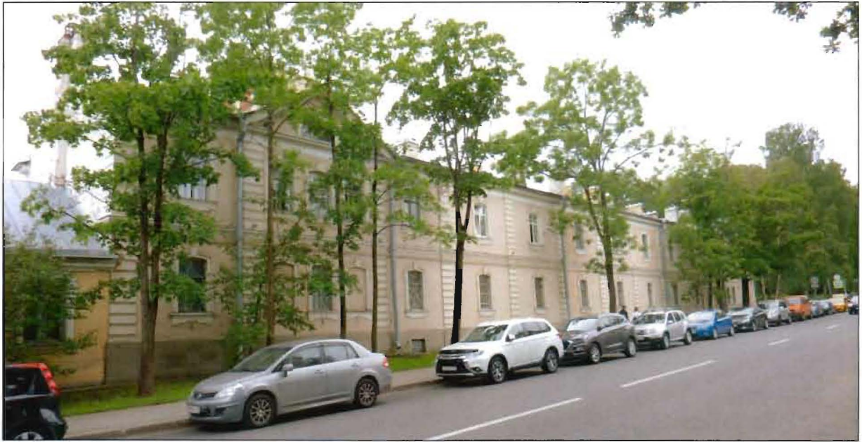
3. Северный фасад. Вид с востока.
