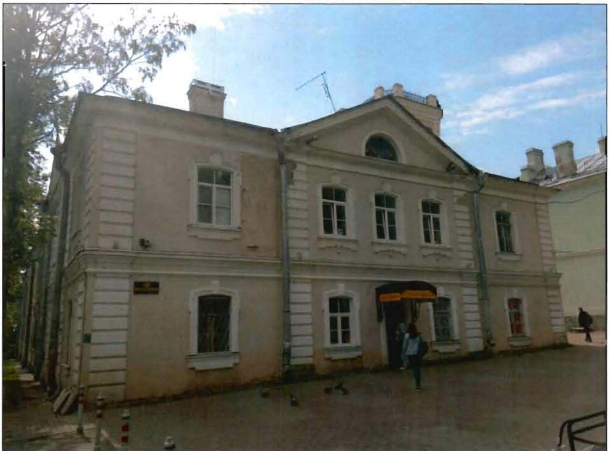
4. Западный фасад. Вид с севера.
