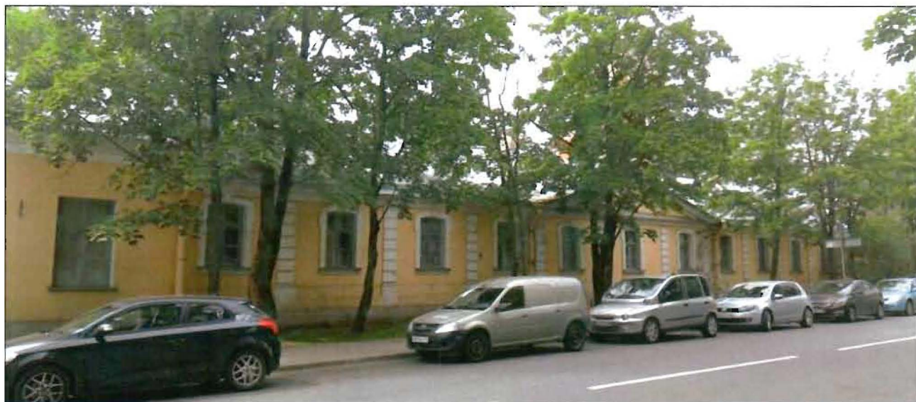
2 Северный фасад. Вид с востока.
