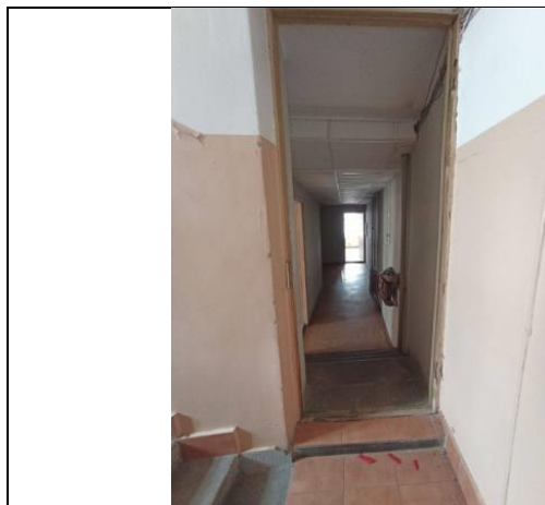
Фото № 13 – Внутреннее состояние помещения
