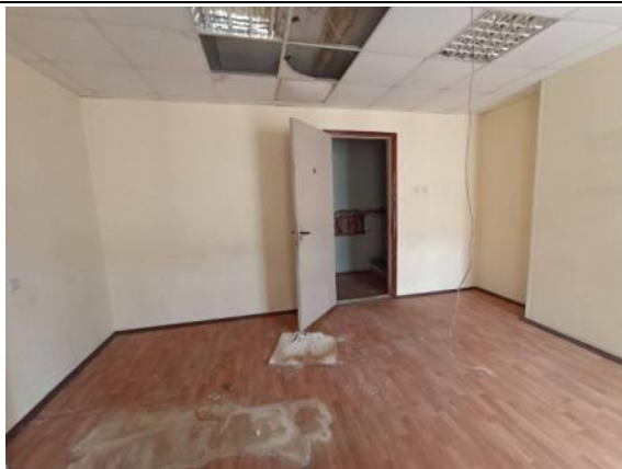
Фото № 9 – Внутреннее состояние помещения
