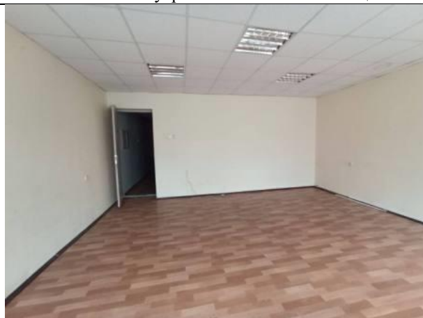
Фото № 15 – Внутреннее состояние помещения
