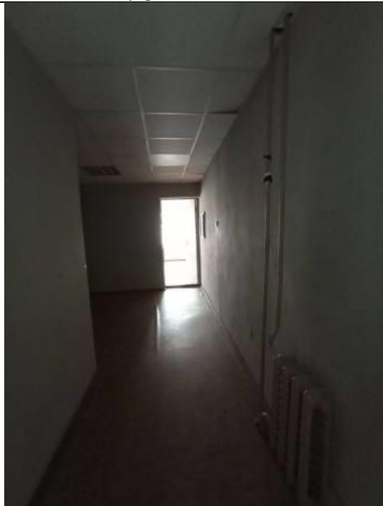
Фото № 11 – Внутреннее состояние помещения
