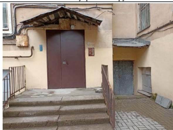
Фото № 5 – Вход в помещение со двора
