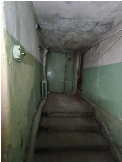
Фото № 9 – Внутреннее состояние помещения
