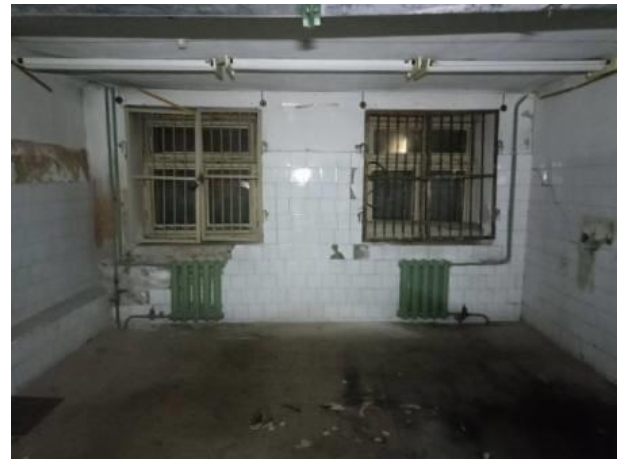
Фото № 10 – Внутреннее состояние помещения
