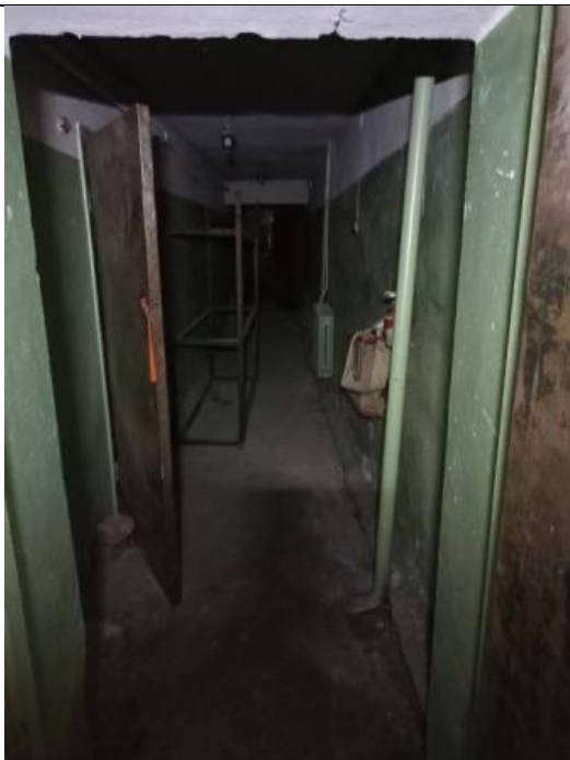
Фото № 13 – Внутреннее состояние помещения
