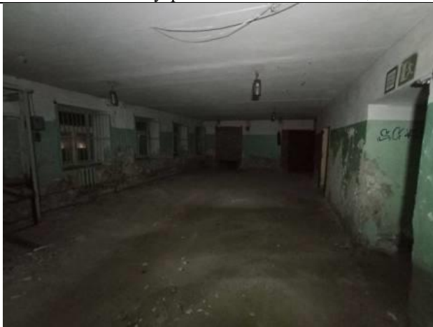
Фото № 11 – Внутреннее состояние помещения
