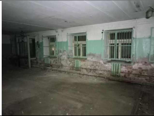
Фото № 7 – Внутреннее состояние помещения
