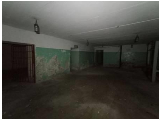
Фото № 8 – Внутреннее состояние помещения
