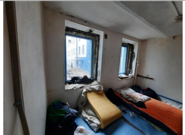
Фото № 8. Внутреннее состояние здания
