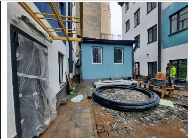
Фото № 5. Внешний вид здания
