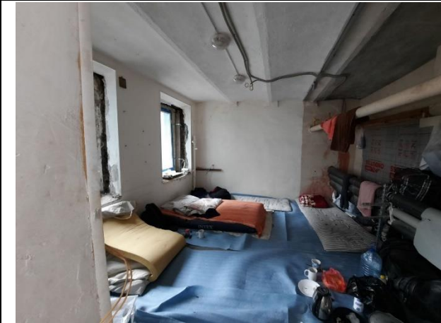
Фото № 7. Внутреннее состояние здания
