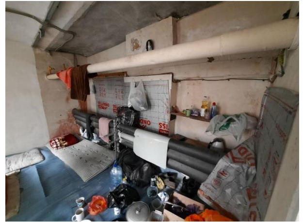
Фото № 10. Внутреннее состояние здания
