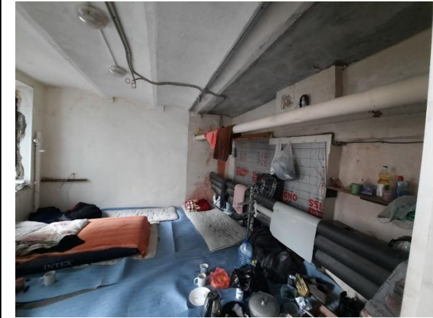
Фото № 9. Внутреннее состояние здания
