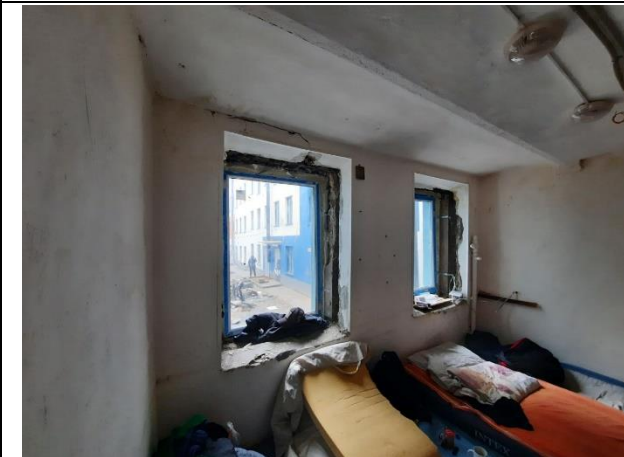
Фото № 11. Внутреннее состояние здания
