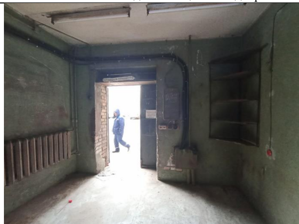
Фото № 10 – Внутреннее состояние помещения
