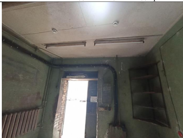
Фото № 9 – Внутреннее состояние помещения
