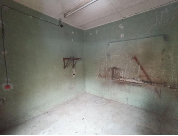
Фото № 11 – Внутреннее состояние помещения
