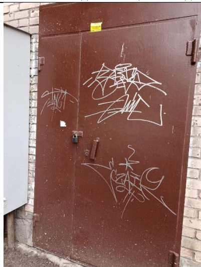
Фото № 10 – Вход в помещение со двора
