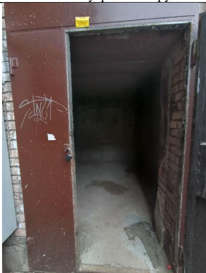
Фото № 9 – Вход в помещение со двора
