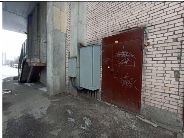
Фото № 8 – Вход в помещение со двора
