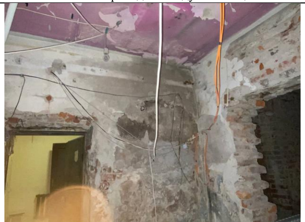
Фото № 8 – Внутреннее состояние помещения
