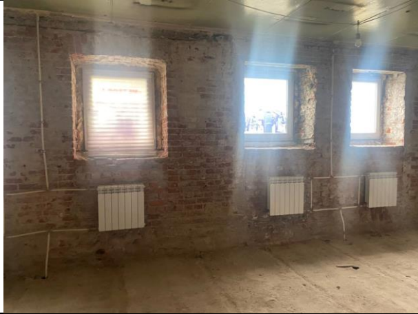
Фото № 19 – Внутреннее состояние помещения
