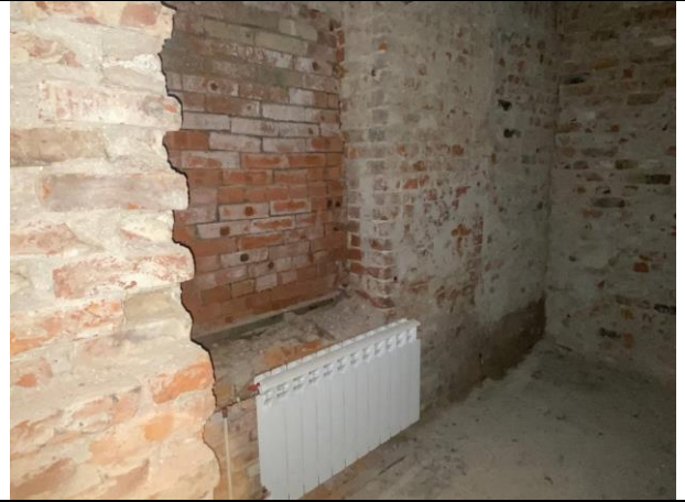
Фото № 12 – Внутреннее состояние помещения
