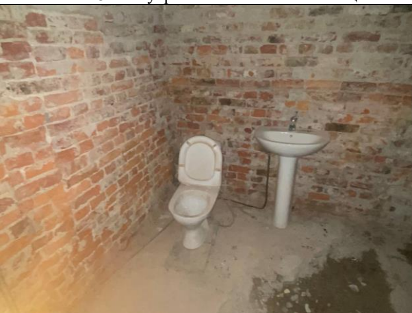
Фото № 17 – Внутреннее состояние помещения
