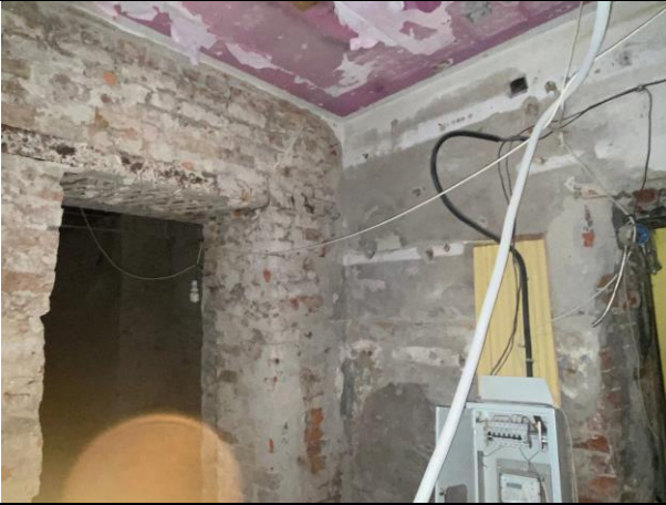
Фото № 11 – Внутреннее состояние помещения
