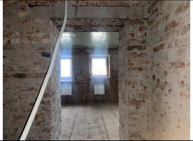
Фото № 20 – Внутреннее состояние помещения
