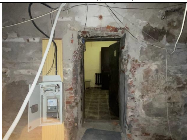
Фото № 9 – Внутреннее состояние помещения
