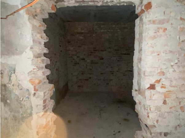
Фото № 13 – Внутреннее состояние помещения
