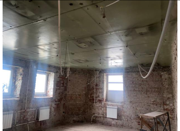
Фото № 22 – Внутреннее состояние помещения
