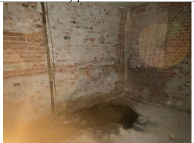
Фото № 16 – Внутреннее состояние помещения
