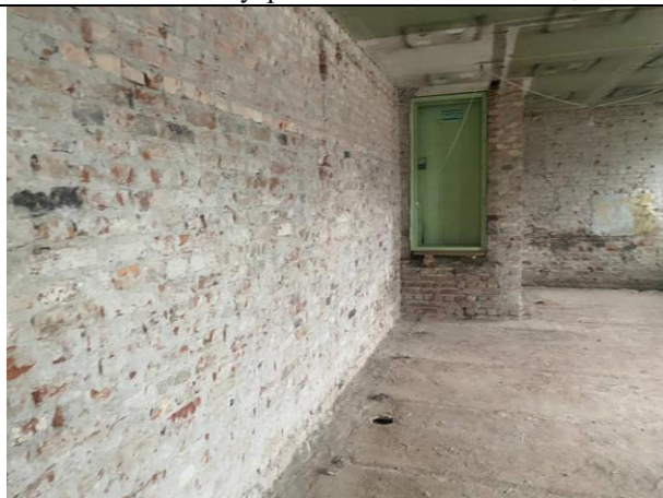
Фото № 23 – Внутреннее состояние помещения
