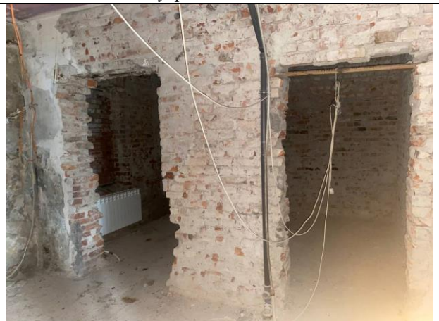
Фото № 24 – Внутреннее состояние помещения
