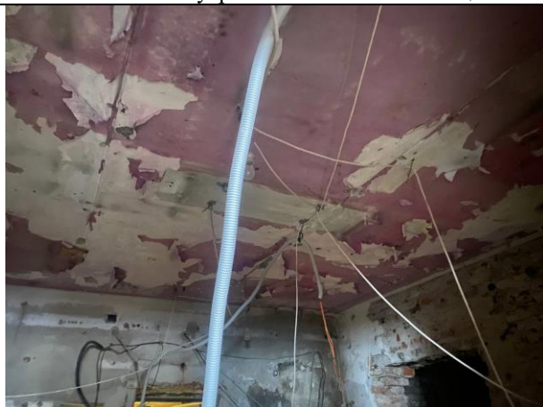
Фото № 25 – Внутреннее состояние помещения
