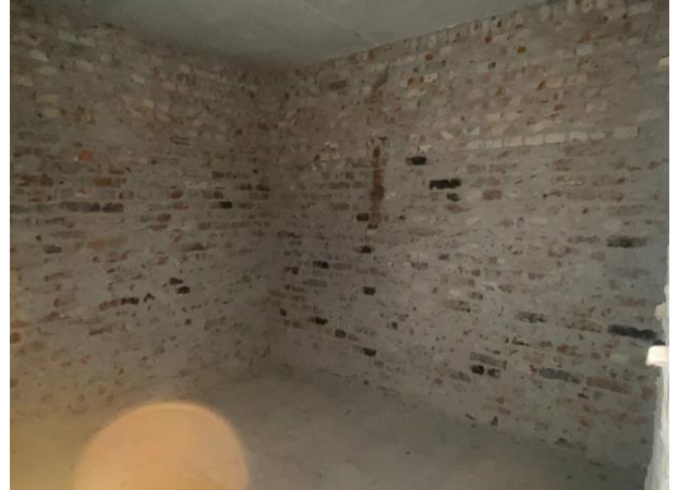
Фото № 14 – Внутреннее состояние помещения
