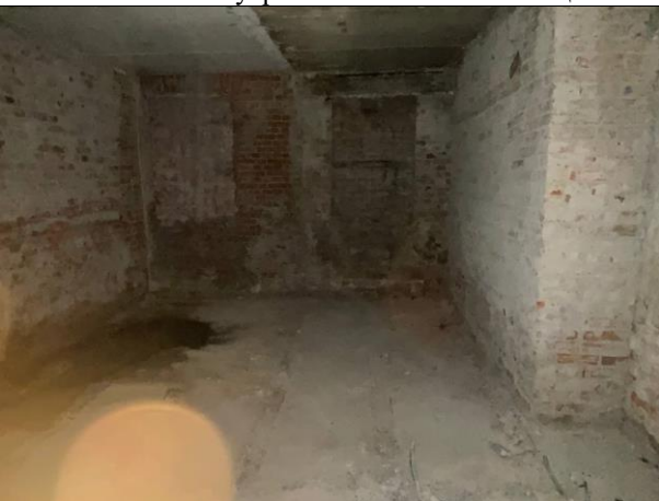
Фото № 15 – Внутреннее состояние помещения
