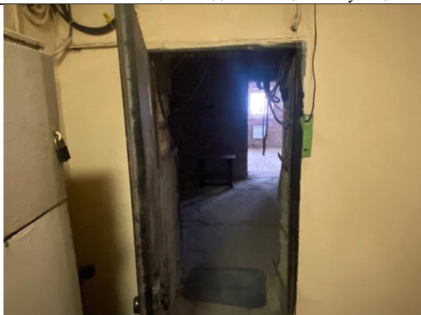
Фото № 7 – Вход в помещение
