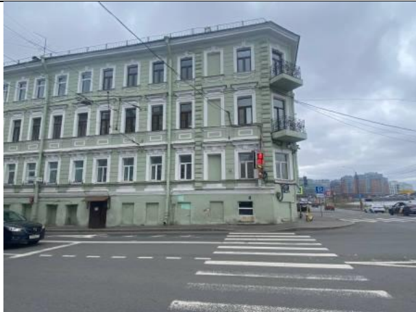
Фото № 3 – Здание, в котором находится Объект оценки
