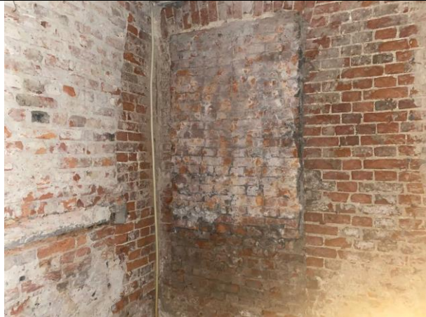
Фото № 21 – Внутреннее состояние помещения
