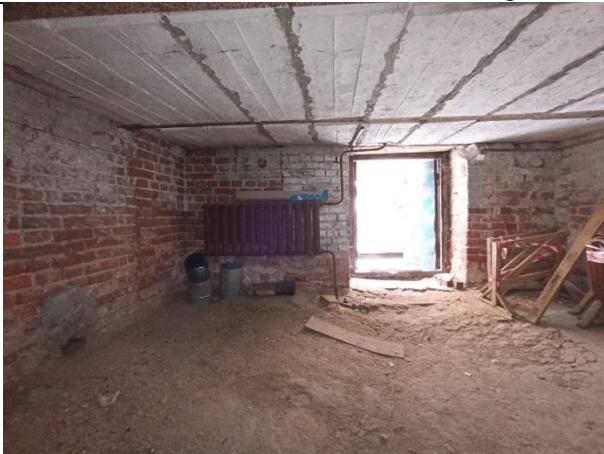
Фото № 11 – Внутреннее состояние помещения
