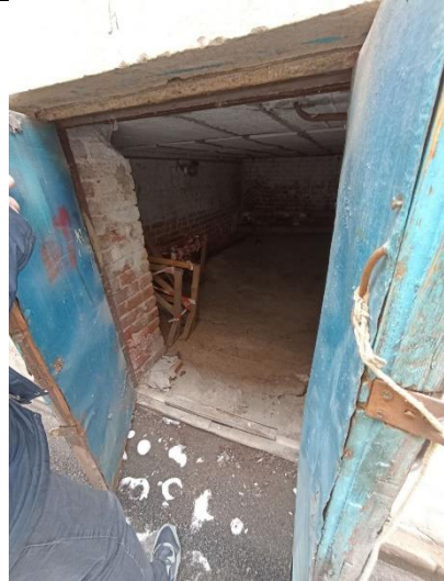
Фото № 10 – Внутреннее состояние помещения
