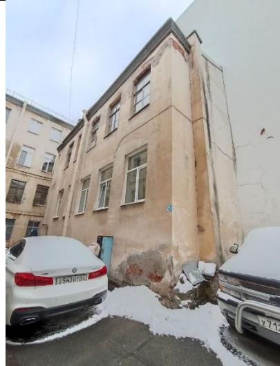
Фото № 8 – Вход в помещение со двора
