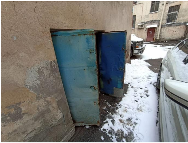
Фото № 9 – Вход в помещение со двора
