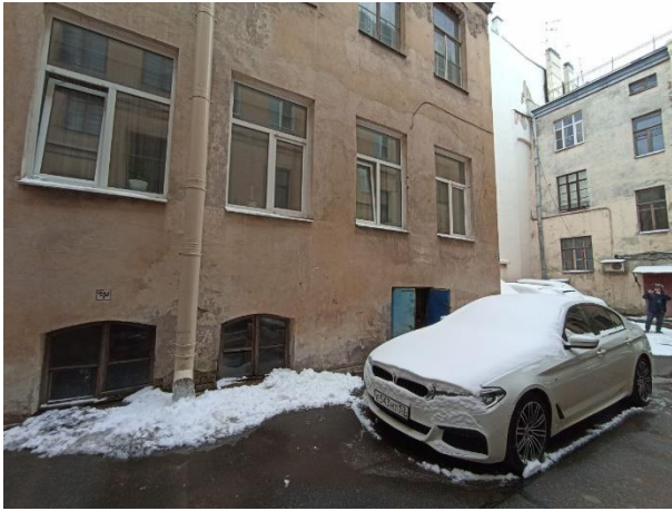
Фото № 7 – Вход в помещение со двора
