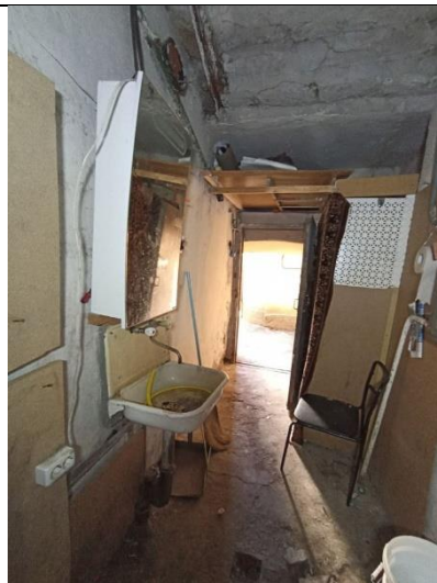
Фото № 6 – Внутреннее состояние помещения
