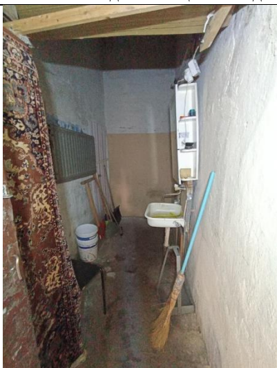
Фото № 7 – Внутреннее состояние помещения
