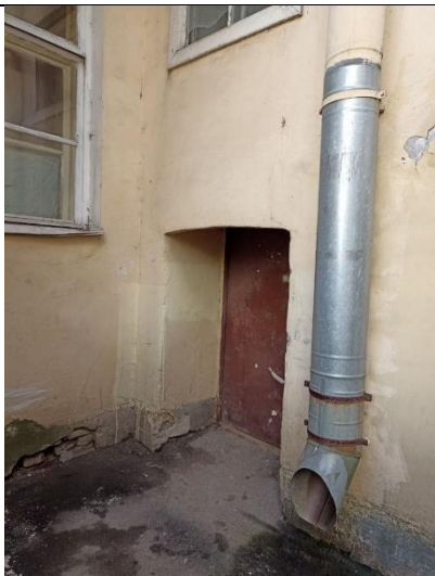
Фото № 5 – Вход в помещение со двора
