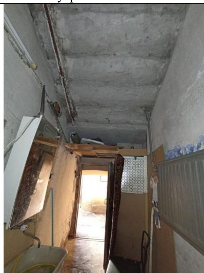
Фото № 8 – Внутреннее состояние помещения
