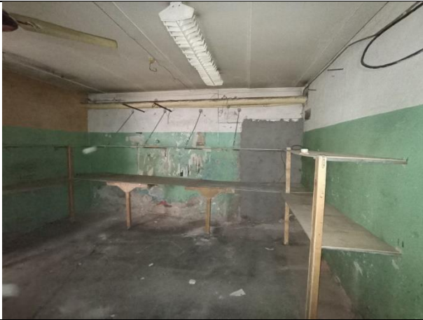
Фото № 15 – Внутреннее состояние помещения
