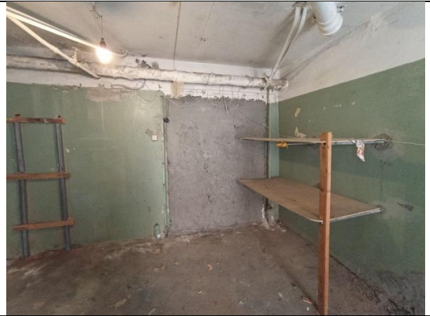
Фото № 16 – Внутреннее состояние помещения
