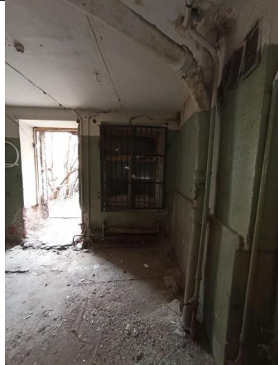
Фото № 14 – Внутреннее состояние помещения
