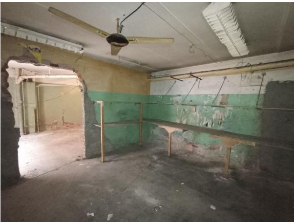
Фото № 11 – Внутреннее состояние помещения
