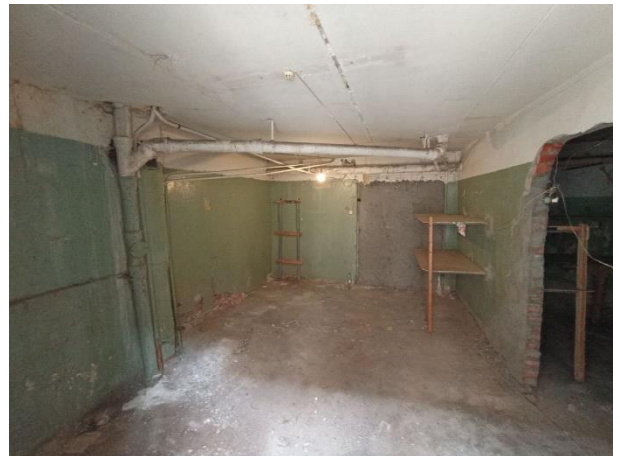
Фото № 12 – Внутреннее состояние помещения
