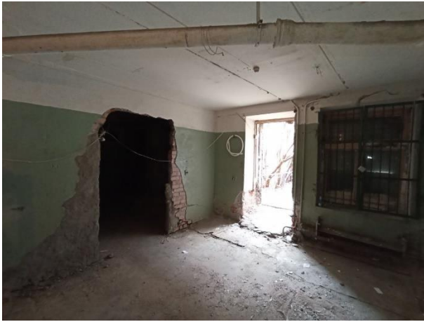
Фото № 13 – Внутреннее состояние помещения
