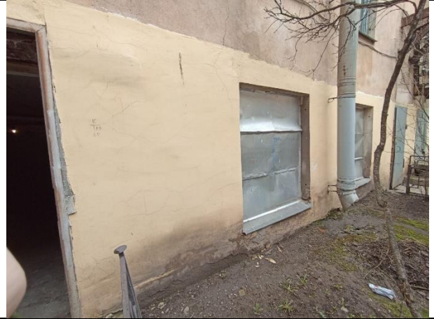
Фото № 8 – Окна помещения
