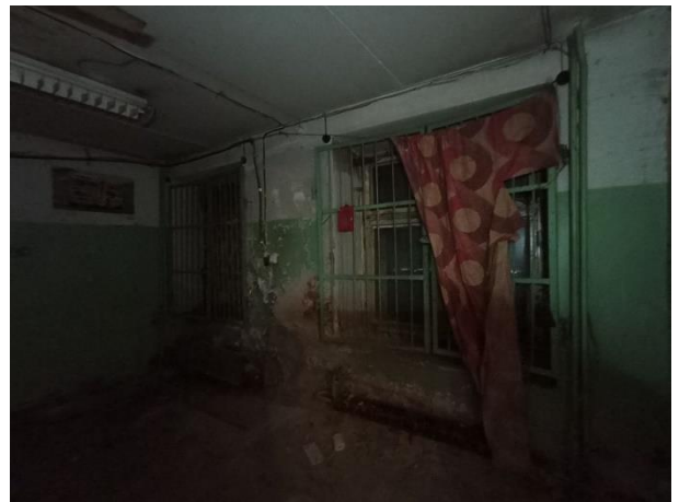
Фото № 10 – Внутреннее состояние помещения
