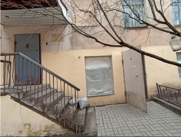
Фото № 7 – Вход в помещение со двора
