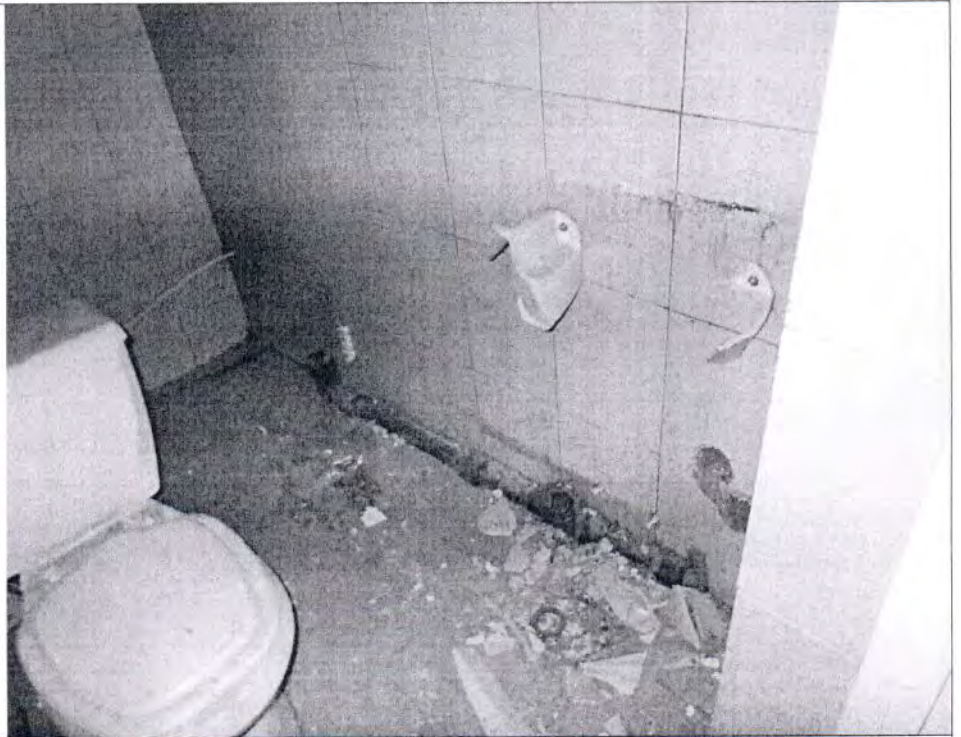
Описание: Вид внутри Объекта (4-Н)
