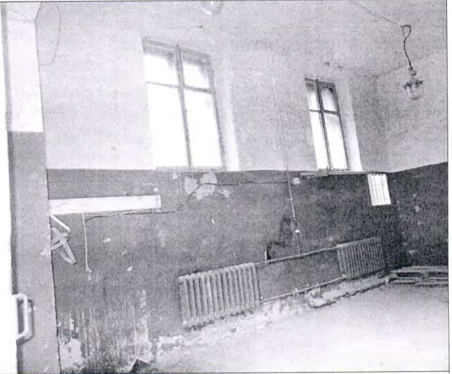
Описание: Вид внутри Объекта (3-Н)
