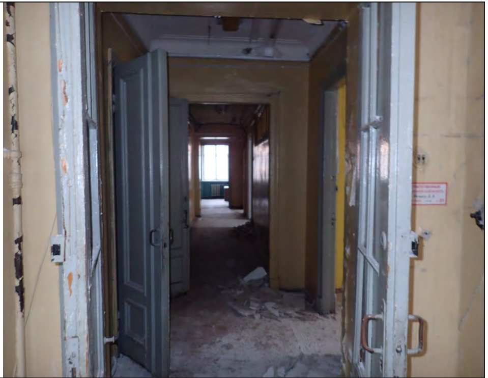
Описание: Вид внутри Объекта (4-Н)
