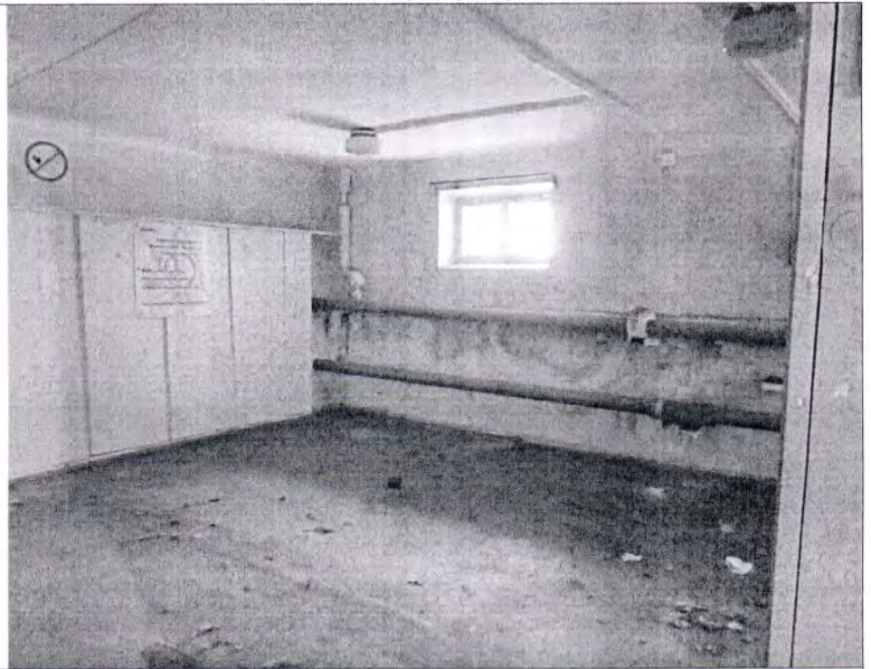
Описание: Вид внутри Объекта (1-Н)
