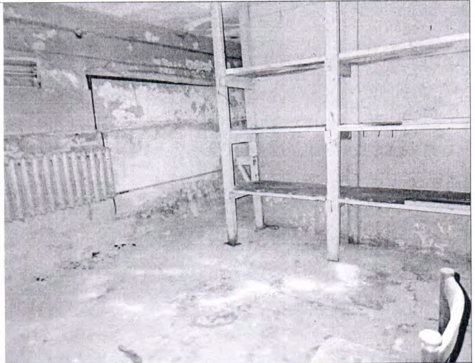
Описание: Вид внутри Объекта (2-Н)
