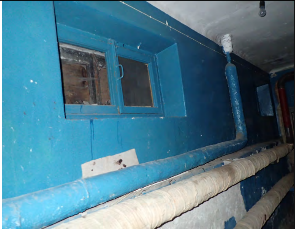
Описание: Вид внутри Объекта (2-Н)
