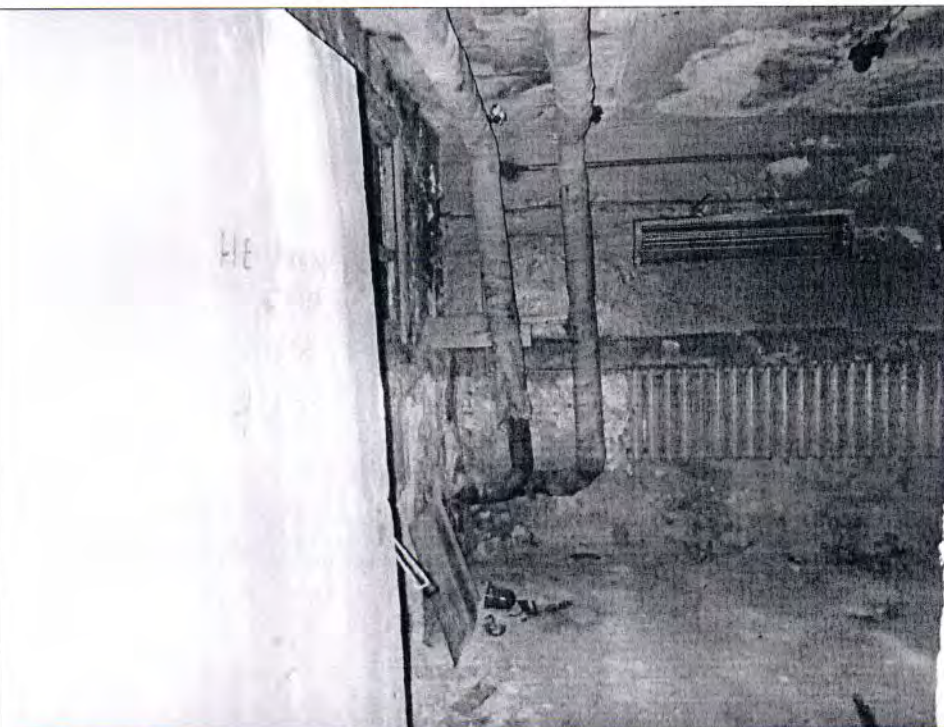
Описание: Вид внутри Объекта (2-Н)
