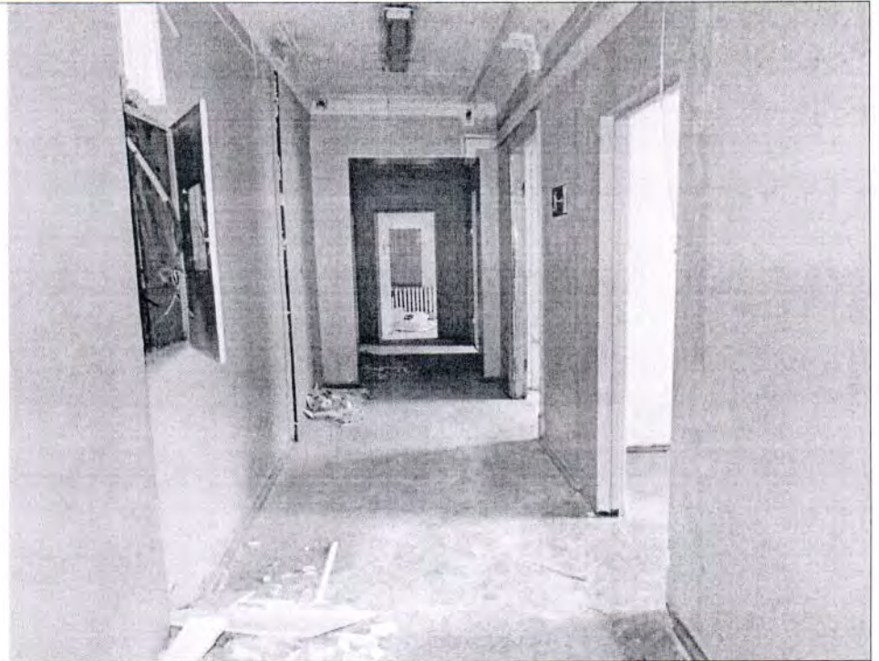
Описание: Вид внутри Объекта (4-Н)
