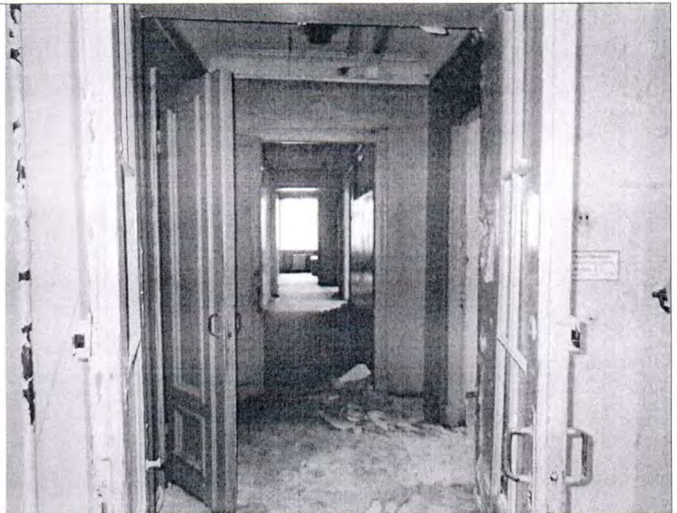
Описание: Вид внутри Объекта (4-Н)
