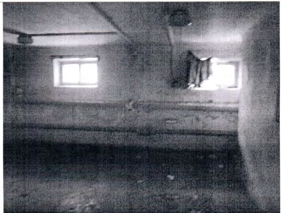
Описание: Вид внутри Объекта (1-Н)
