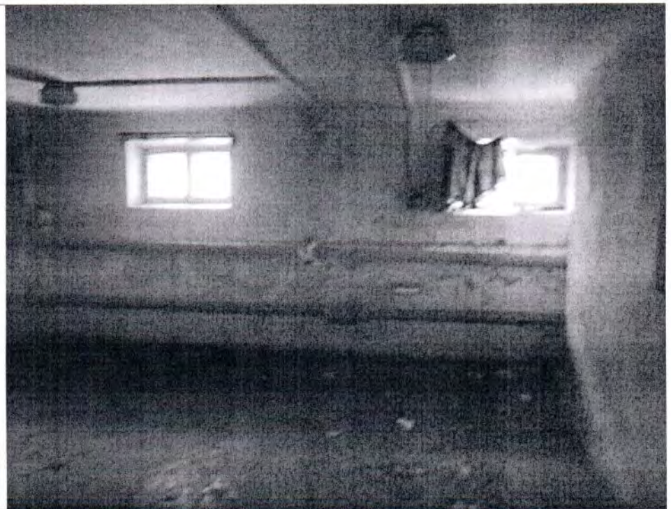
Описание: Вид внутри Объекта (1-Н)
