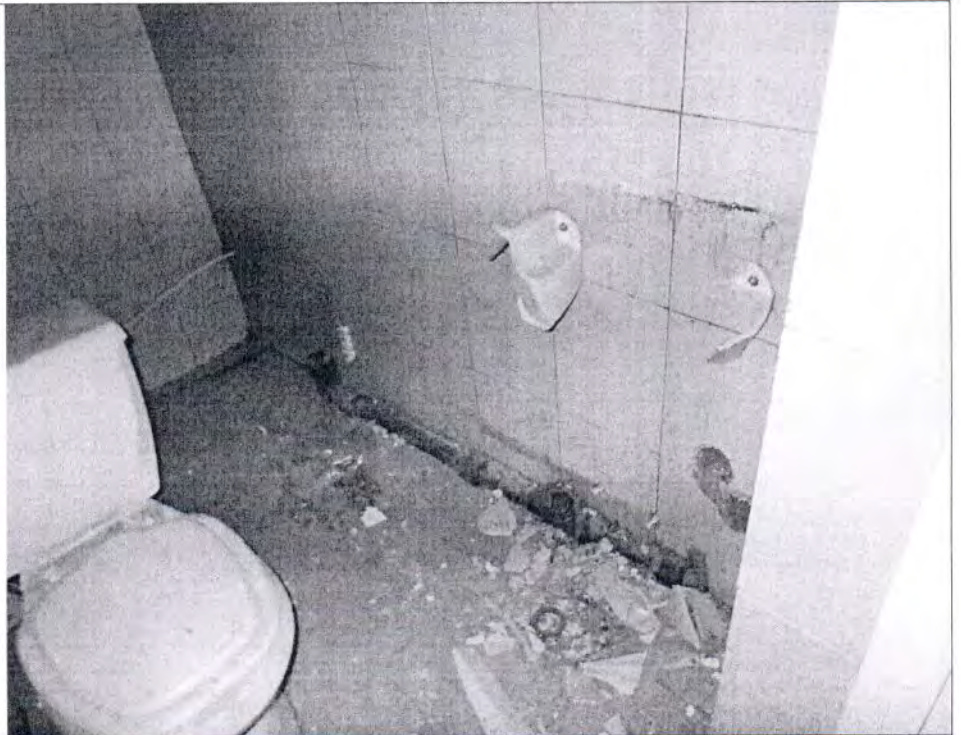
Описание: Вид внутри Объекта (4-Н)
