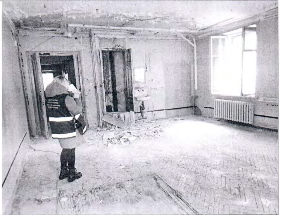
Описание: Вид внутри Объекта (4-Н)
