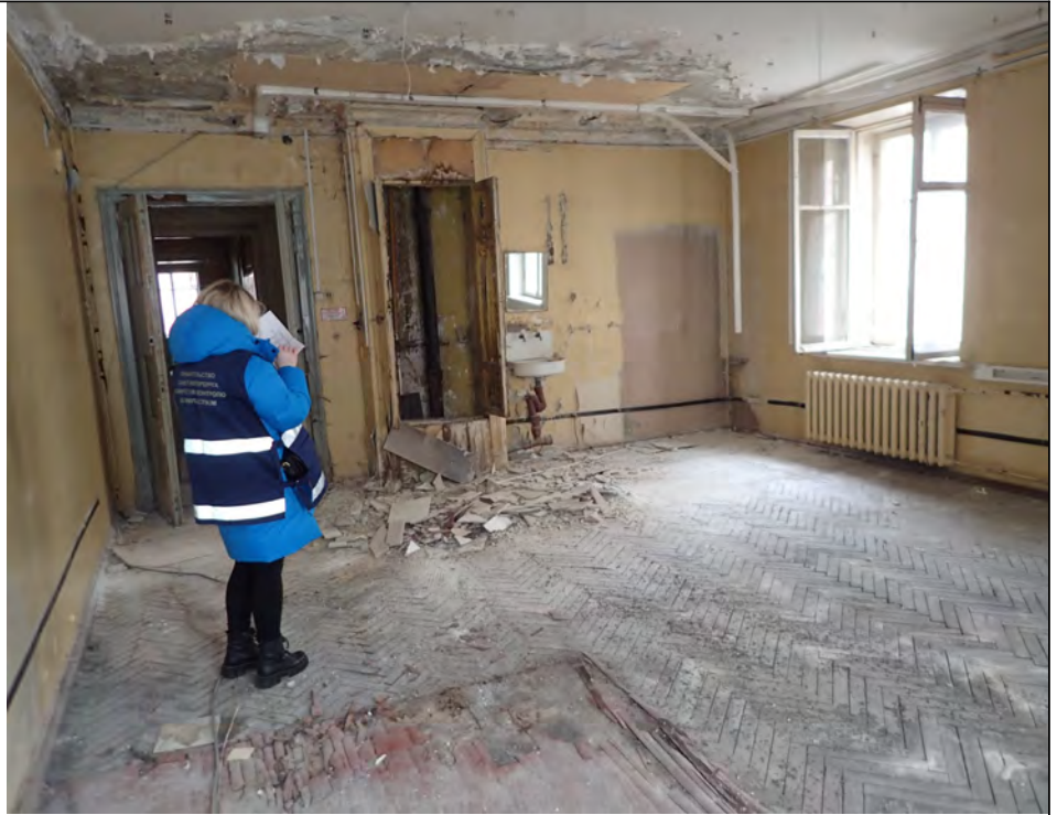
Описание: Вид внутри Объекта (4-Н)
