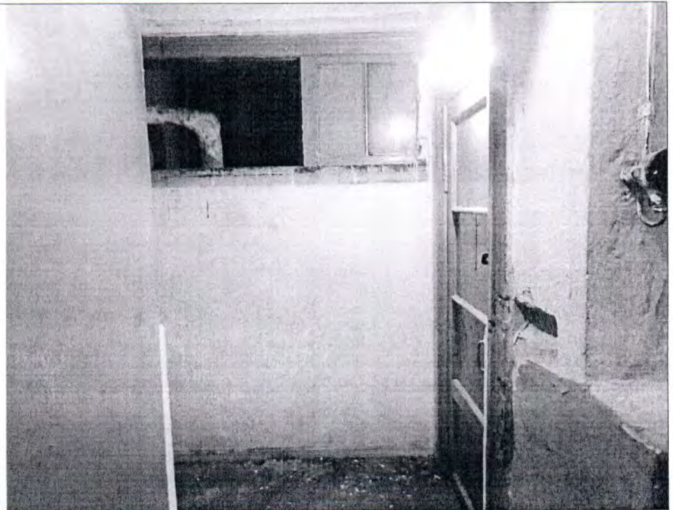
Описание: Вид внутри Объекта (1-Н)
