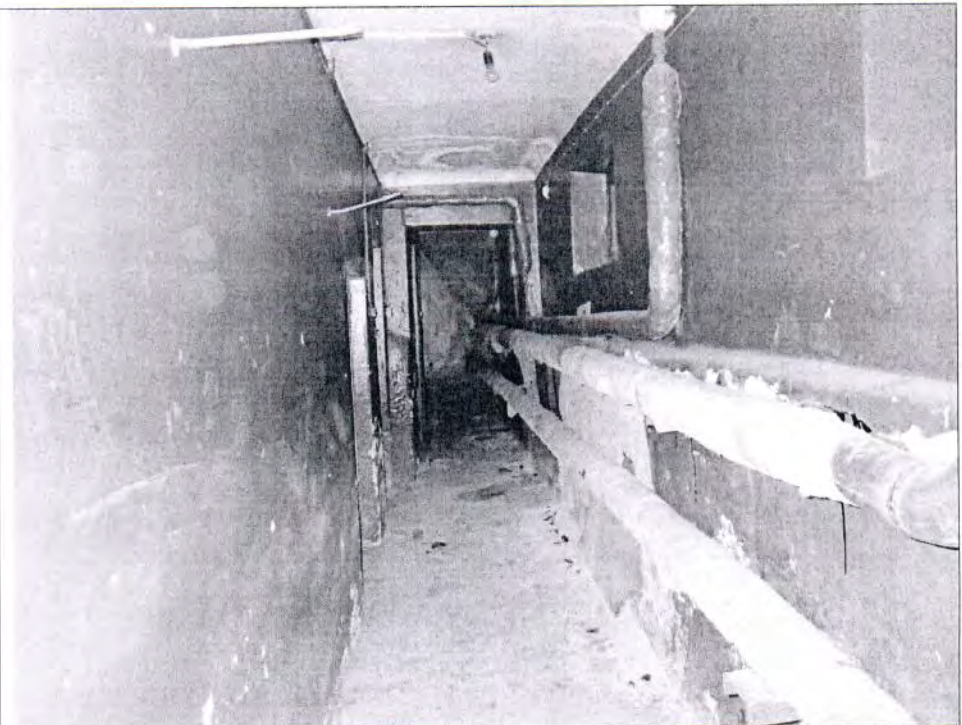
Описание: Вид внутри Объекта (2-Н)
