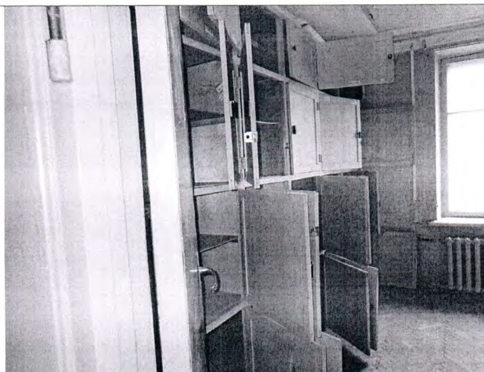
Описание: Вид внутри Объекта (4-Н)
