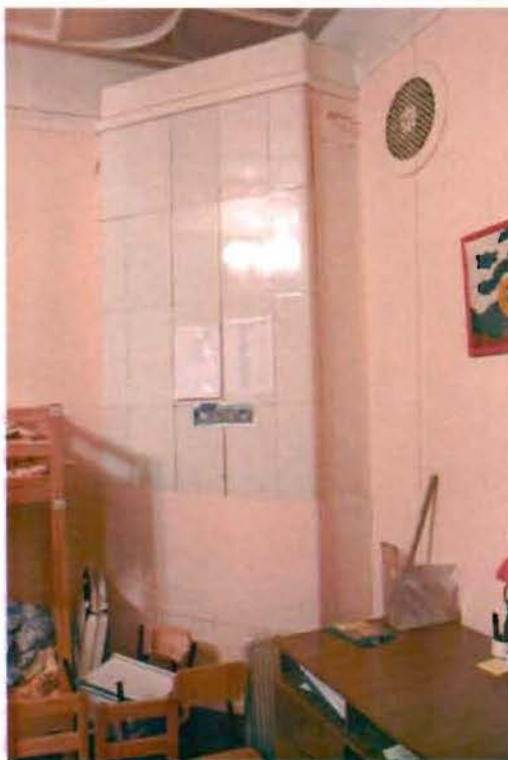
Фото № 16. Печь в пом. 2-Н (38).
