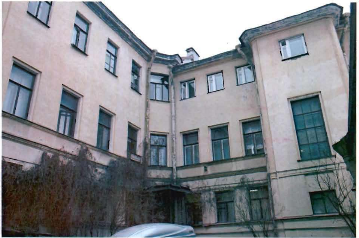
Фото №2. Вид на восточный и северный корпус со стороны внутреннего двора.
