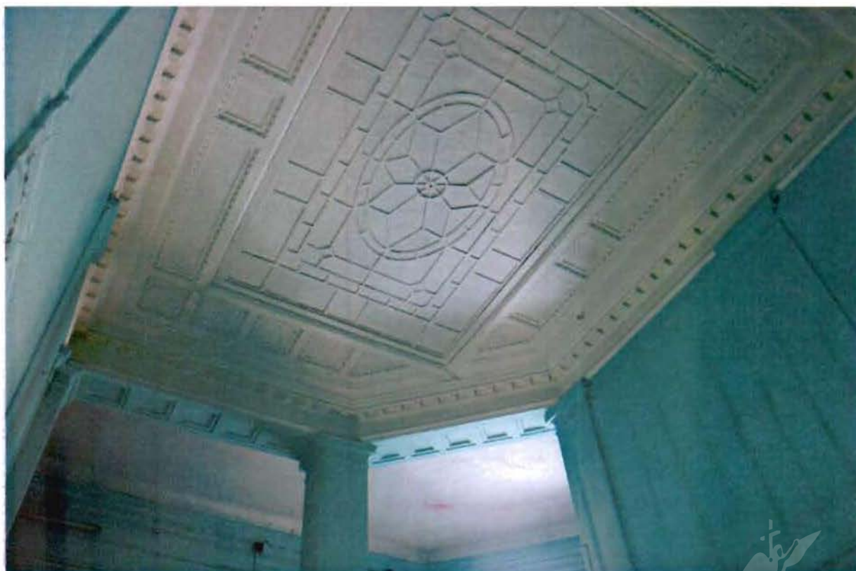
Фото № 22, 23, 24. Лестничная клетка Л-2 восточного корпуса.
