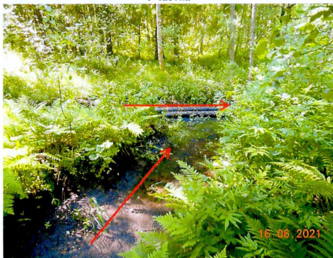
Фото №3. Устьевой участок водоотводной канавы, проходящей по территории Участка
