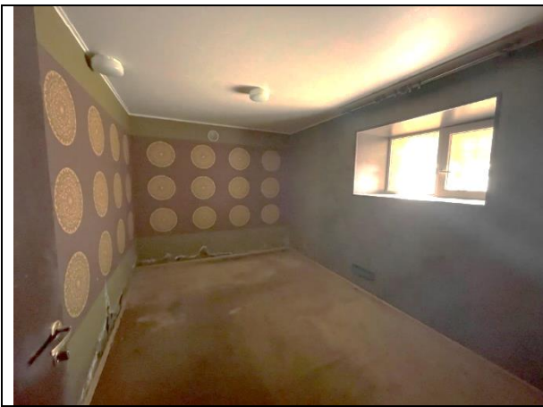
Фото 29. Типичное состояние Объекта оценки
