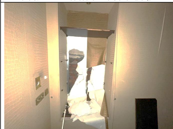
Фото 41. Типичное состояние Объекта оценки
