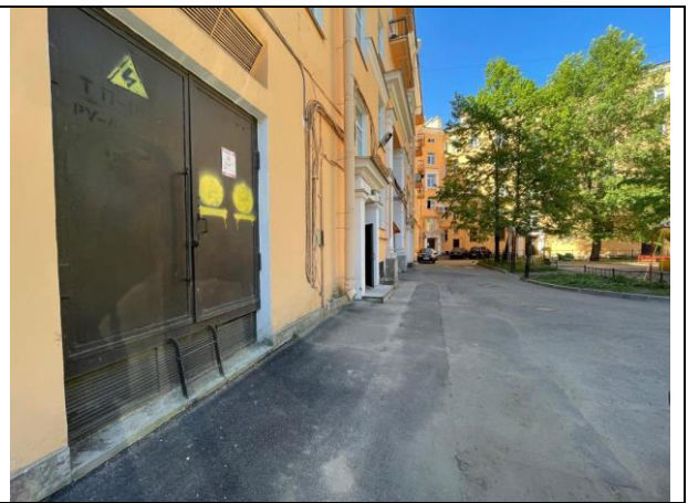
Фото 14. Вид здания расположения Объекта оценки
