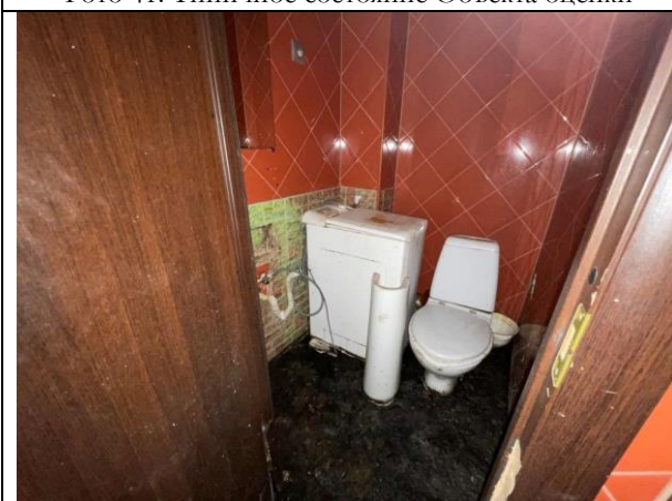
Фото 43. Типичное состояние Объекта оценки
