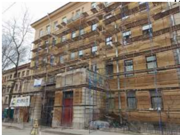
Фото 1. Вид здания, в котором расположен Объект оценки
