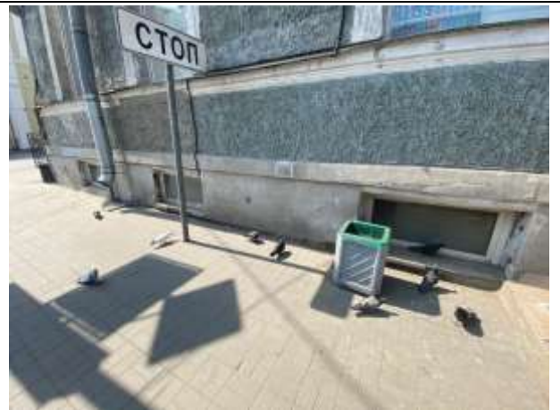
Фото 6 Окна помещения 1-Н
