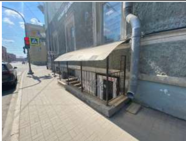
Фото 5 Отдельный вход с улицы
