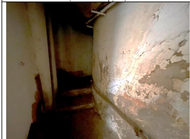
Фото 43. Типичное состояние Объекта оценки (тепловые трубы)
