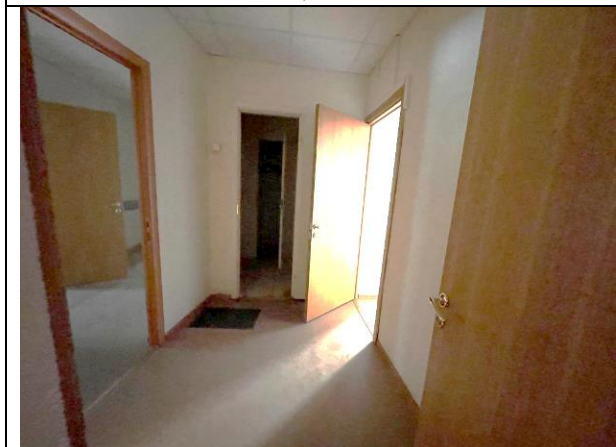
Фото 83. Типичное состояние второго этажа Объекта оценки
