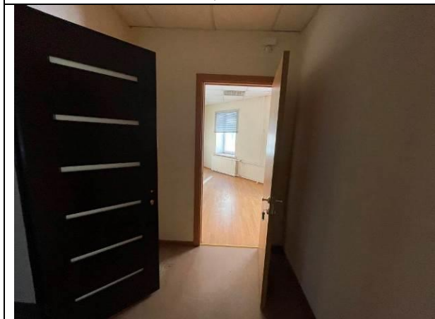
Фото 91. Типичное состояние второго этажа Объекта оценки
