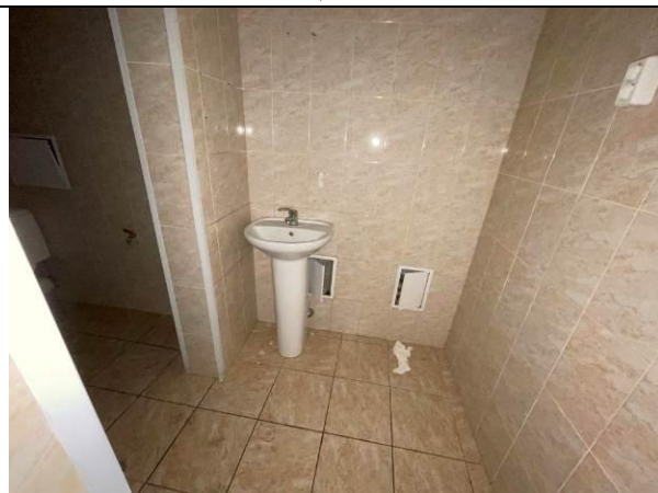
Фото 98. Типичное состояние второго этажа Объекта оценки
