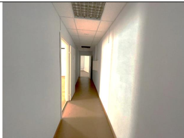
Фото 96. Типичное состояние второго этажа Объекта оценки
