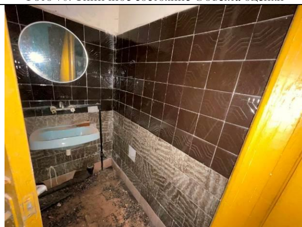
Фото 72. Типичное состояние Объекта оценки
