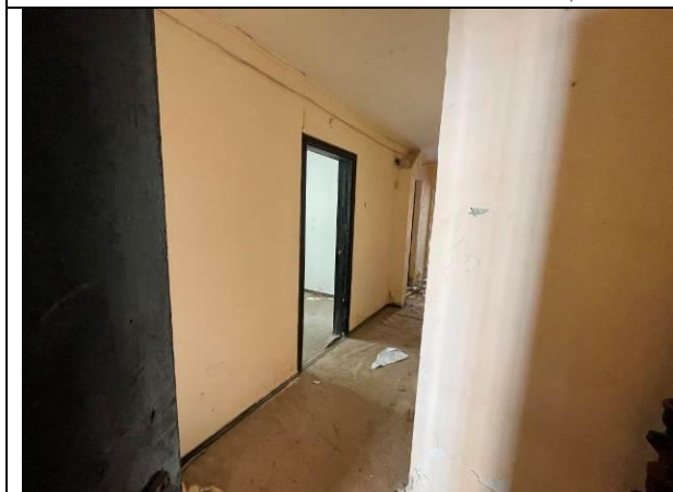
Фото 37. Типичное состояние Объекта оценки
