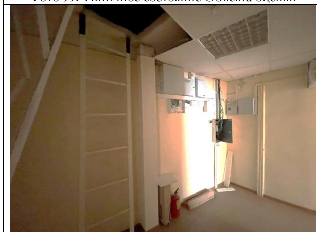
Фото 101. Типичное состояние Объекта оценки
