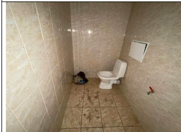
Фото 97. Типичное состояние второго этажа Объекта оценки
