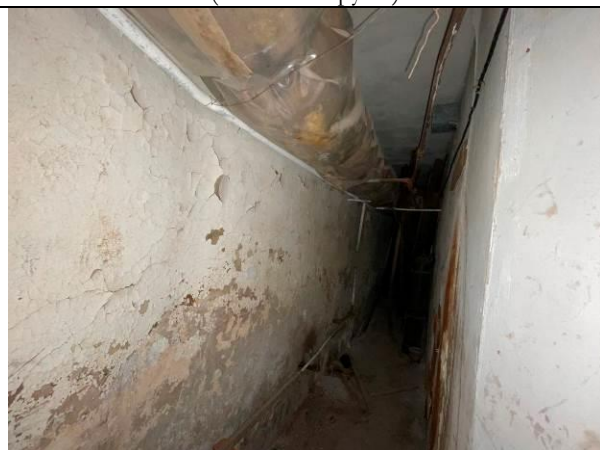
Фото 42. Типичное состояние Объекта оценки (тепловые трубы)
