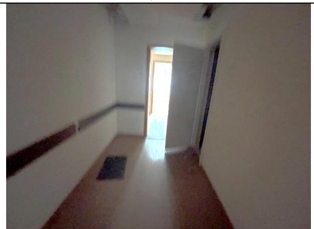
Фото 84. Типичное состояние второго этажа Объекта оценки
