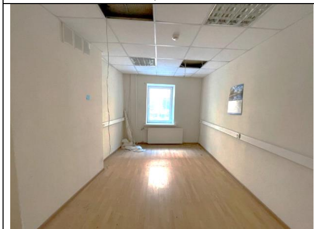
Фото 85. Типичное состояние второго этажа Объекта оценки
