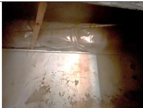
Фото 40. Типичное состояние Объекта оценки (тепловые трубы)
