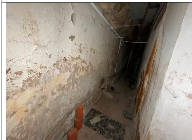
Фото 41. Типичное состояние Объекта оценки (тепловые трубы)
