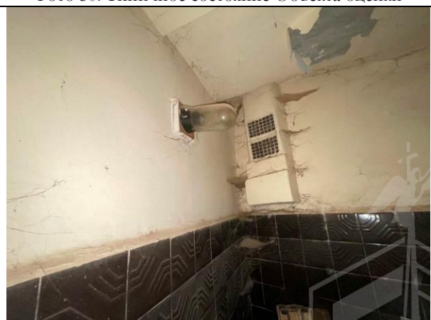
Фото 52. Типичное состояние Объекта оценки (вход)
