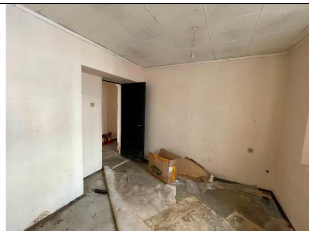
Фото 32. Типичное состояние Объекта оценки
