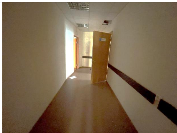
Фото 94. Типичное состояние второго этажа Объекта оценки
