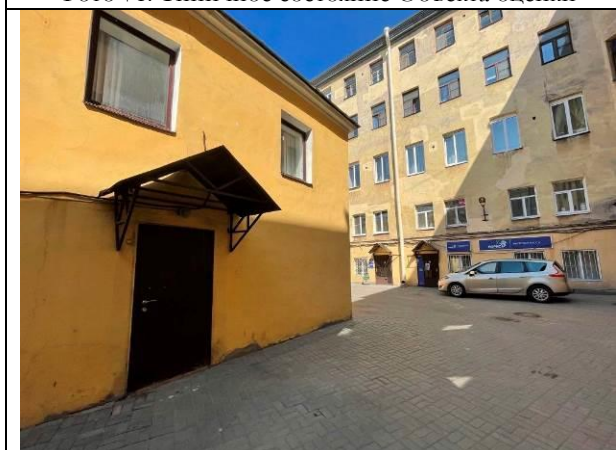
Фото 73. Входная и оконная группа Объекта оценки
