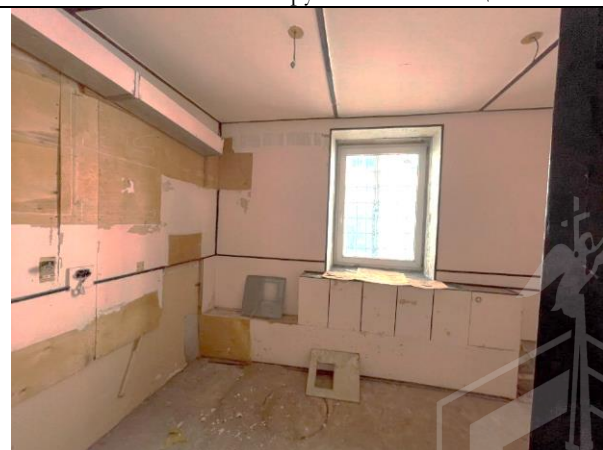
Фото 38. Типичное состояние Объекта оценки
