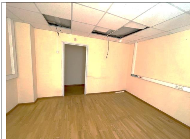
Фото 99. Типичное состояние Объекта оценки
