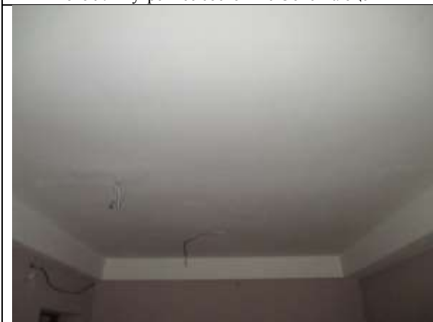
Фото 11. Внутреннее состояние Объекта оценки
