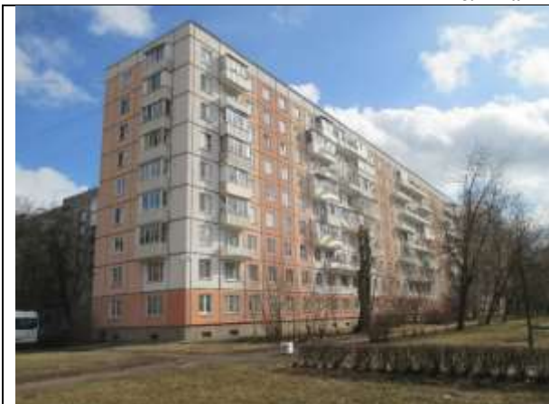
Фото 1. Вид здания, в котором расположен Объект оценки
