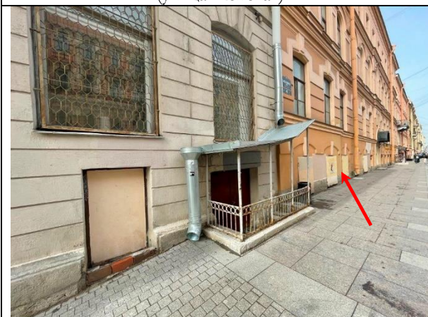
Фото 7. Вид здания Объекта оценки, оконная группа Объекта оценки
