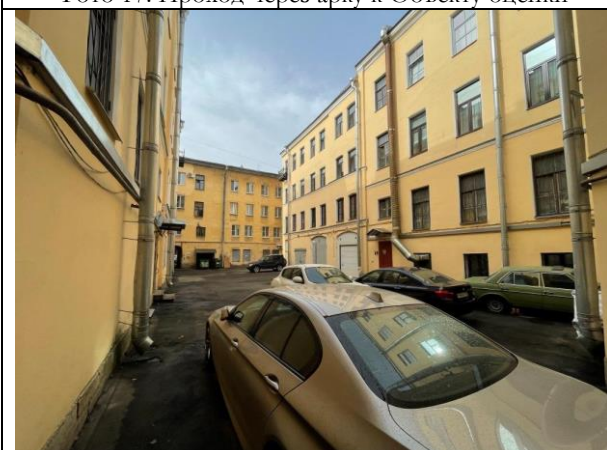
Фото 19. Внутридворовая территория Объекта оценки
