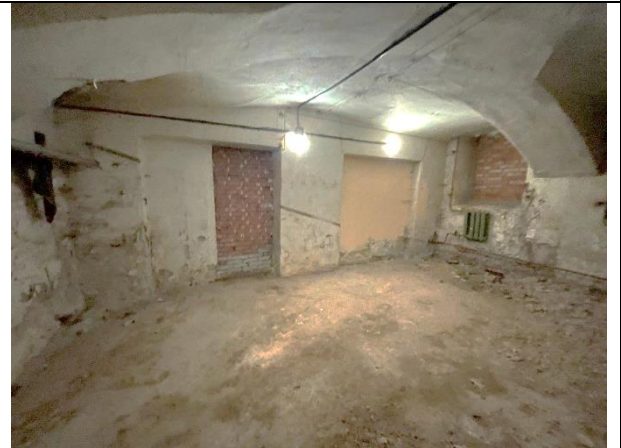
Фото 40. Типичное состояние Объекта оценки
