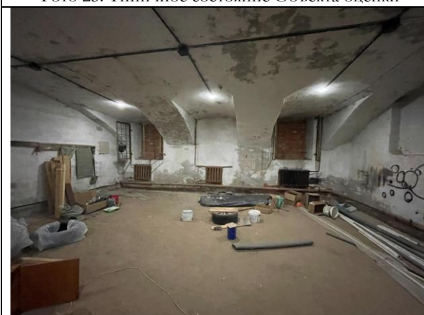
Фото 27. Типичное состояние Объекта оценки
