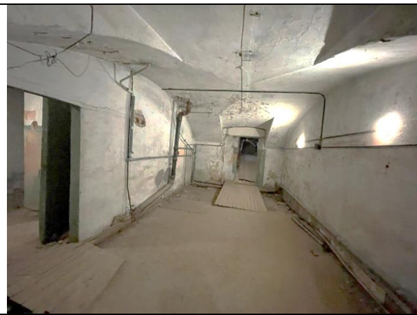
Фото 29. Типичное состояние Объекта оценки
