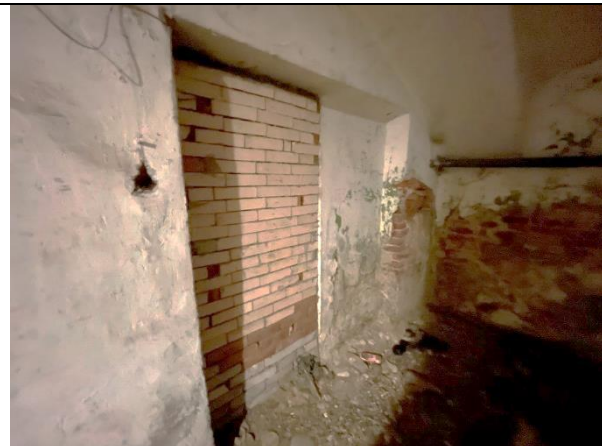
Фото 33. Типичное состояние Объекта оценки
