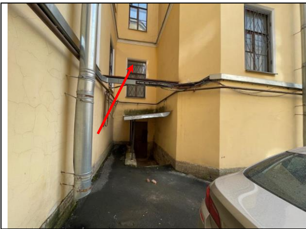
Фото 21. Вид здания расположения Объекта оценки
