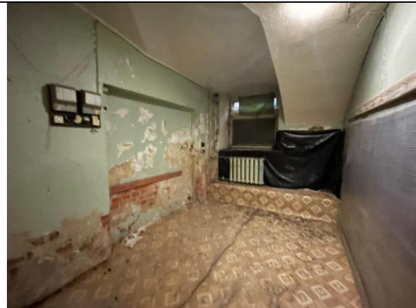
Фото 31. Типичное состояние Объекта оценки
