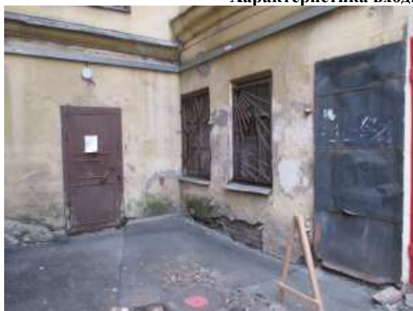
Фото 5. 2 отдельных входа со двора и окна Объекта оценки
