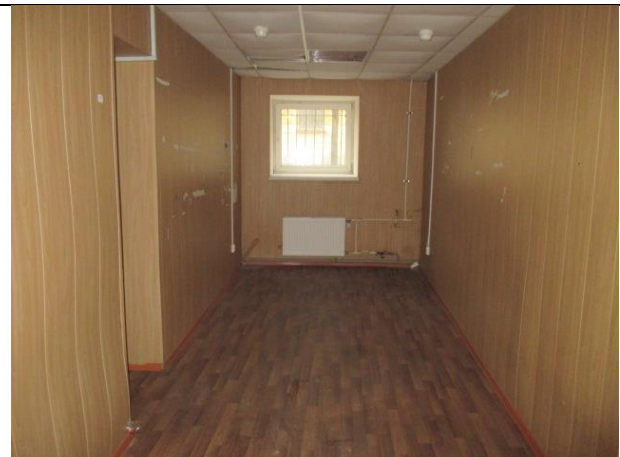
Фото № 14 – Внутреннее состояние помещения
