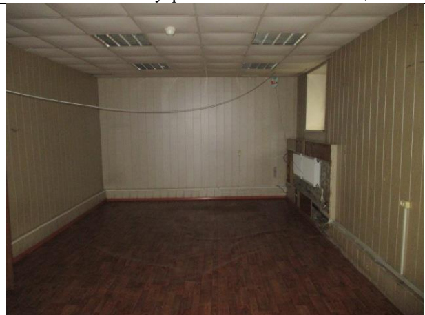
Фото № 24 – Внутреннее состояние помещения
