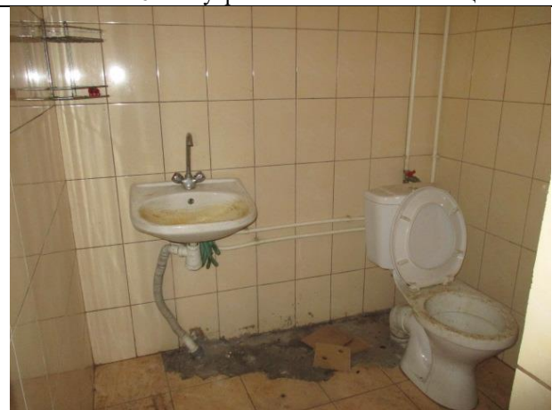
Фото № 18 – Внутреннее состояние помещения
