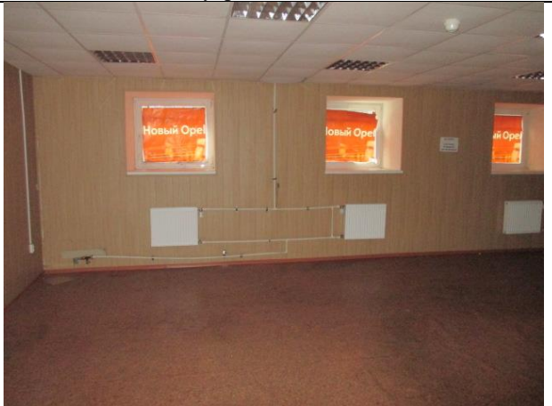
Фото № 16 – Внутреннее состояние помещения
