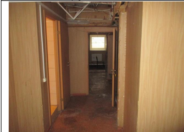
Фото № 15 – Внутреннее состояние помещения
