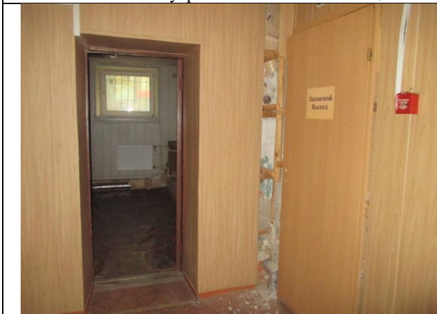
Фото № 23 – Внутреннее состояние помещения
