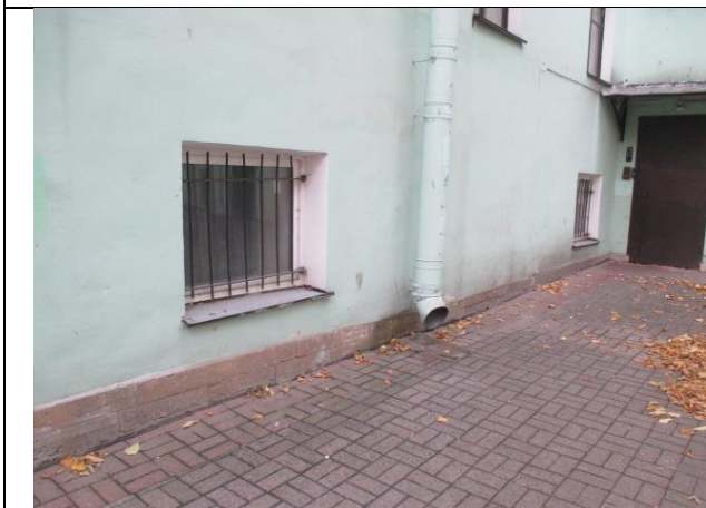
Фото № 9 – Расположение окон в помещении
