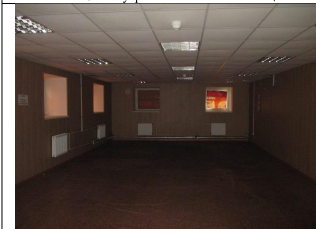
Фото № 17 – Внутреннее состояние помещения
