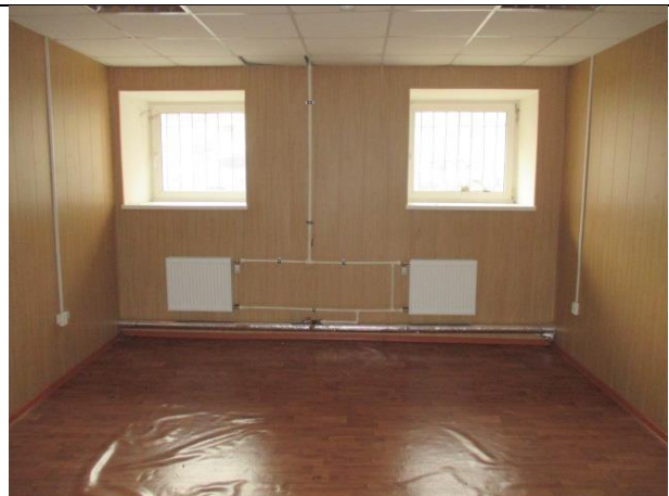
Фото № 22 – Внутреннее состояние помещения
