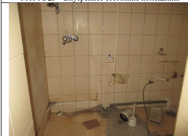
Фото № 25 – Внутреннее состояние помещения
