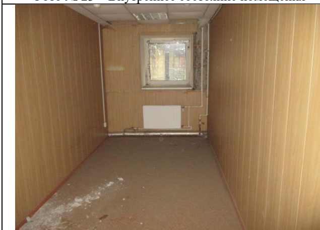
Фото № 27 – Внутреннее состояние помещения
