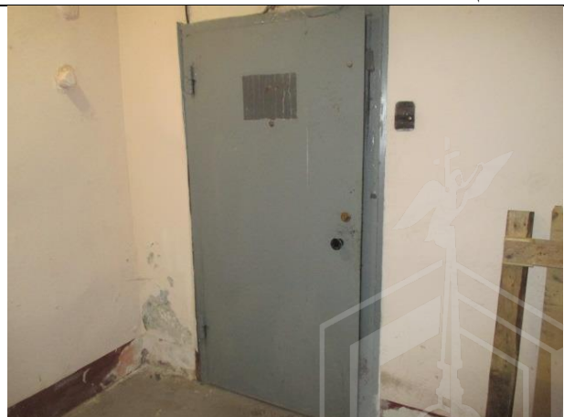
Фото № 12 – Вход в помещение
