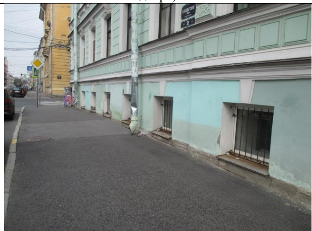
Фото № 10 – Расположение окон в помещении
