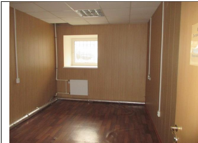
Фото № 21 – Внутреннее состояние помещения
