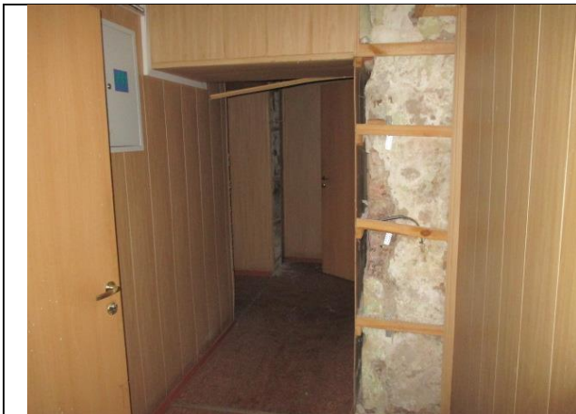
Фото № 13 – Внутреннее состояние помещения
