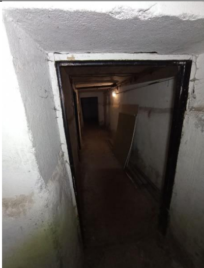
Фото № 13 – Внутреннее состояние помещения
