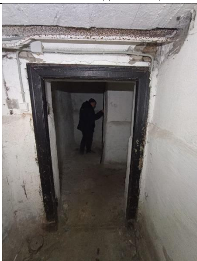
Фото № 9 – Внутреннее состояние помещения
