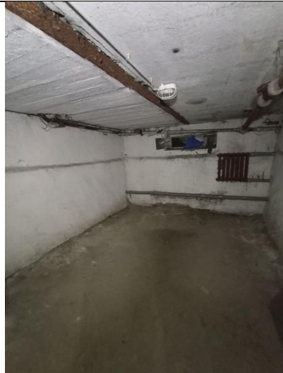
Фото № 14 – Внутреннее состояние помещения
