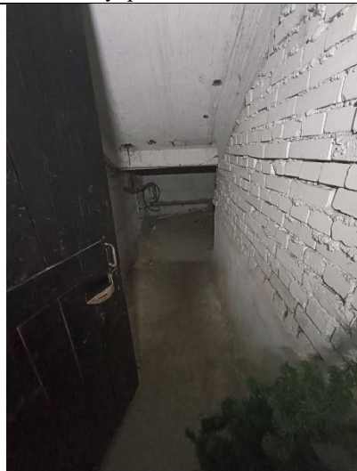
Фото № 16 – Внутреннее состояние помещения
