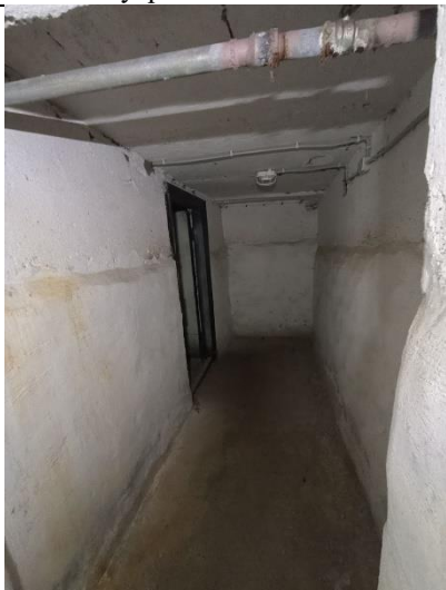
Фото № 11 – Внутреннее состояние помещения
