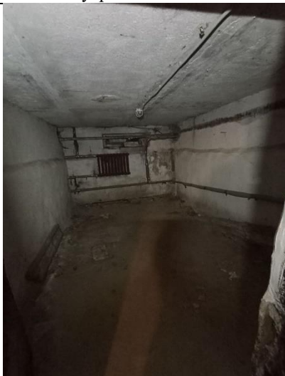
Фото № 17 – Внутреннее состояние помещения
