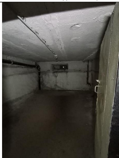
Фото № 10 – Внутреннее состояние помещения
