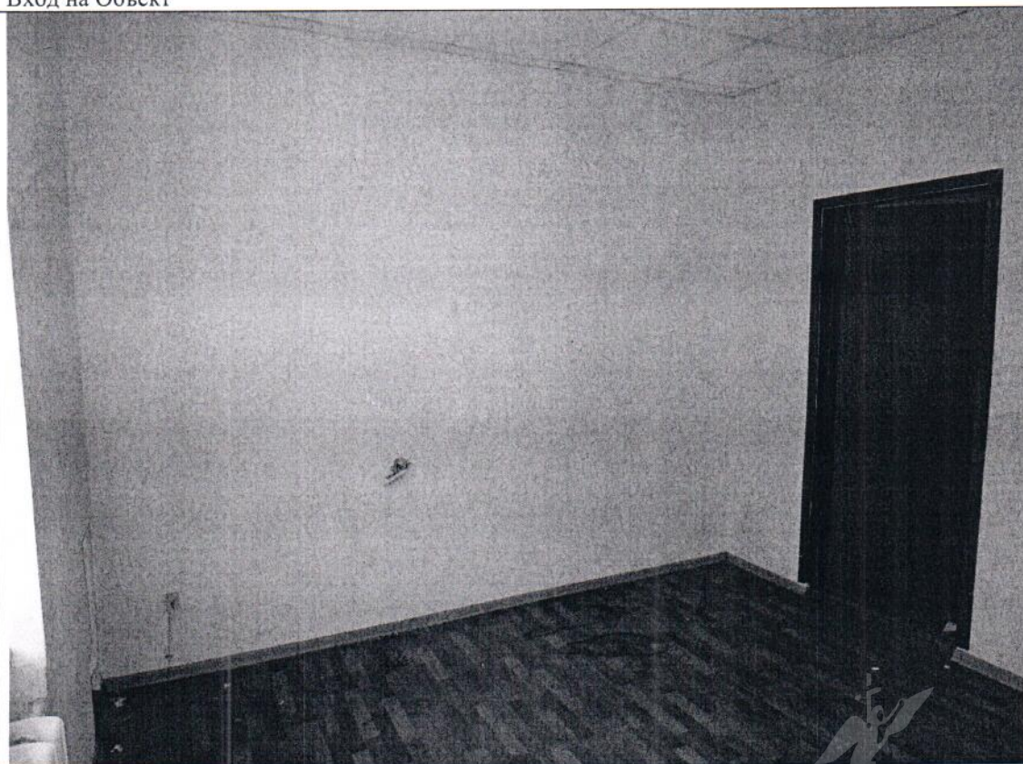
Описание: между ч.п. 1 и 2 Объекта заложен дверной проем
