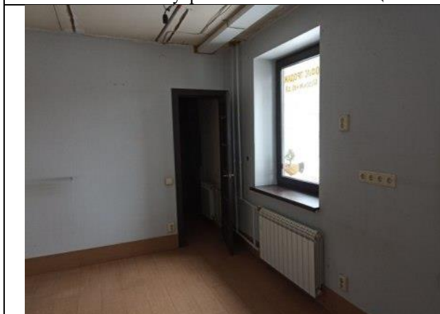
Фото № 13 – Внутреннее состояние помещения
