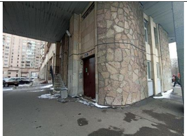
Фото № 6 – Общий вход в помещение
