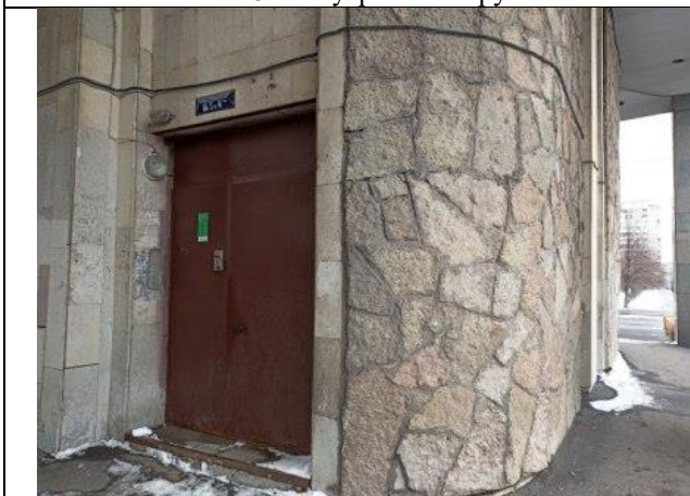
Фото № 7 – Общий вход в помещение
