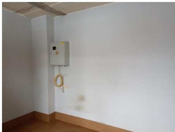
Фото № 18 – Внутреннее состояние помещения
