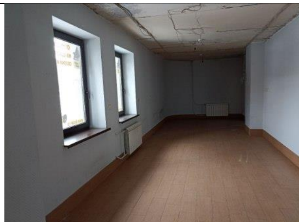
Фото № 12 – Внутреннее состояние помещения
