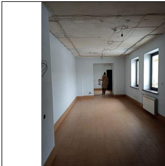
Фото № 17 – Внутреннее состояние помещения
