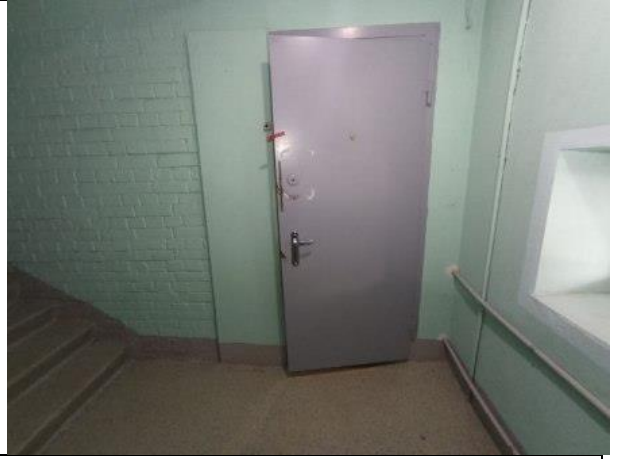
Фото № 6 – Вход в помещение
