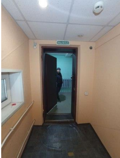
Фото № 7 – Внутреннее состояние помещения
