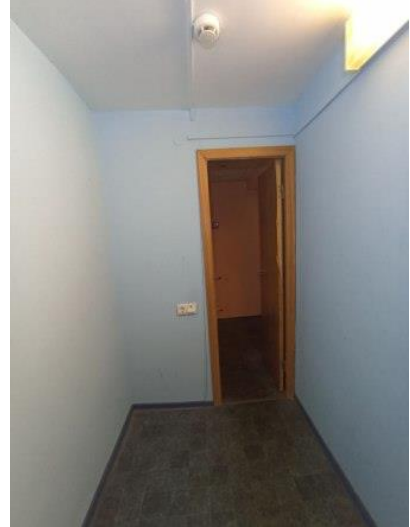
Фото № 8 – Внутреннее состояние помещения
