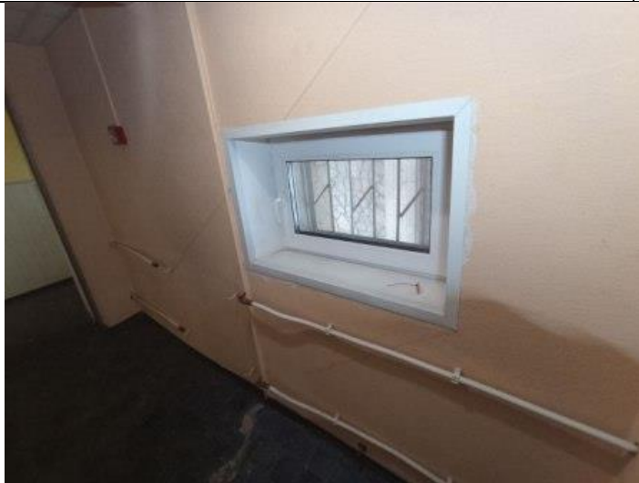
Фото № 13 – Внутреннее состояние помещения
