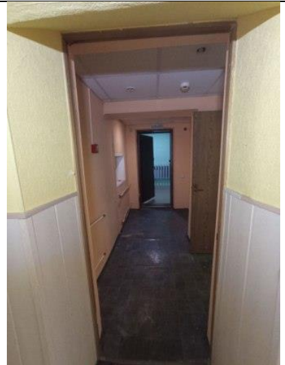
Фото № 18 – Внутреннее состояние помещения
