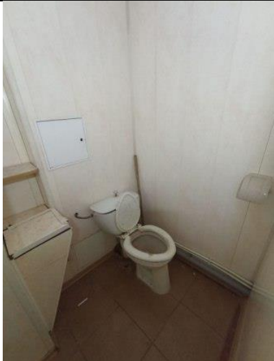
Фото № 9 – Внутреннее состояние помещения
