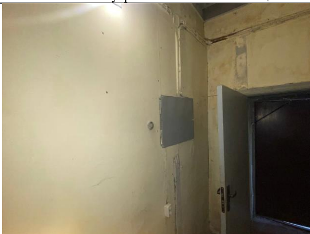
Фото № 25 – Внутреннее состояние помещения
