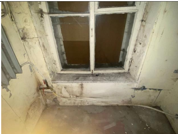
Фото № 19 – Внутреннее состояние помещения
