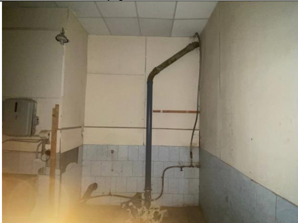
Фото № 2115 – Внутреннее состояние помещения
