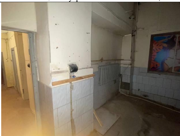
Фото № 23 – Внутреннее состояние помещения
