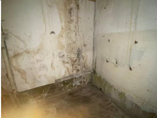
Фото № 13 – Внутреннее состояние помещения
