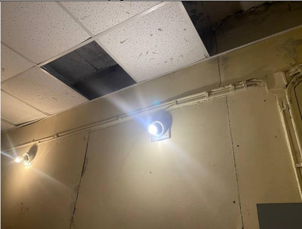
Фото № 29 – Внутреннее состояние помещения
