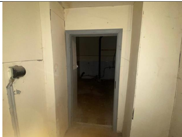
Фото № 20 – Внутреннее состояние помещения
