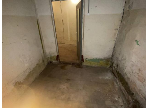
Фото № 14 – Внутреннее состояние помещения
