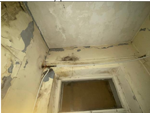
Фото № 17 – Внутреннее состояние помещения
