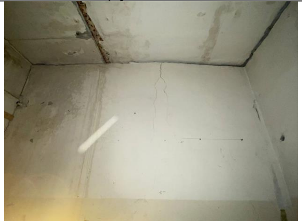
Фото № 30 – Внутреннее состояние помещения
