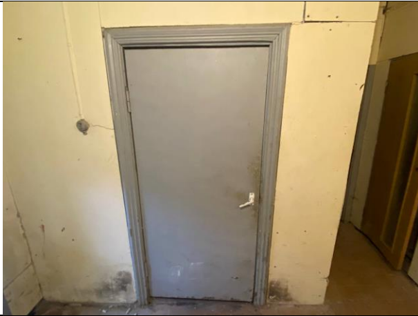
Фото № 11 – Внутреннее состояние помещения
