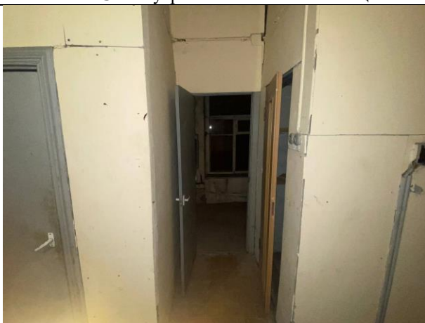
Фото № 15 – Внутреннее состояние помещения
