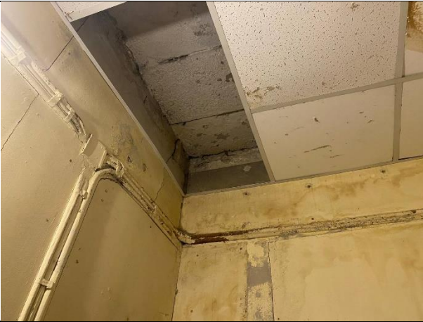
Фото № 27 – Внутреннее состояние помещения
