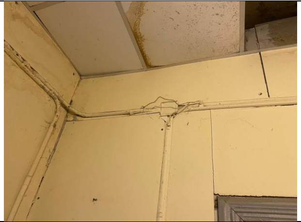
Фото № 28 – Внутреннее состояние помещения
