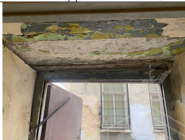
Фото № 26 – Внутреннее состояние помещения
