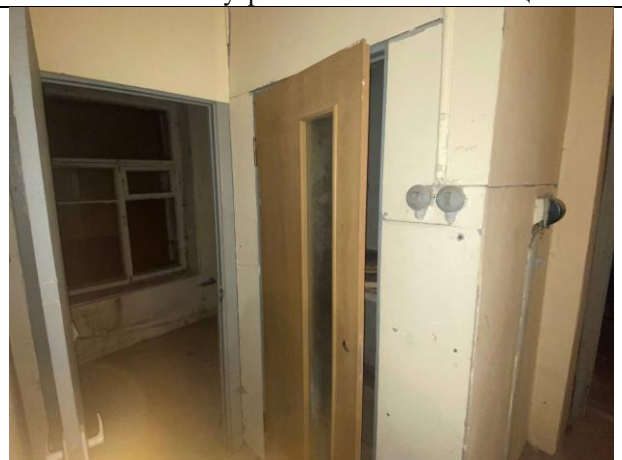
Фото № 16 – Внутреннее состояние помещения
