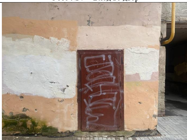
Фото № 9 – Вход в помещение со двора
