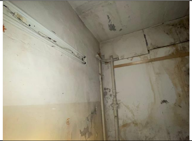
Фото № 12 – Внутреннее состояние помещения
