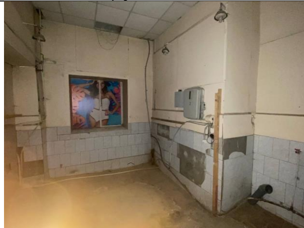
Фото № 22 – Внутреннее состояние помещения
