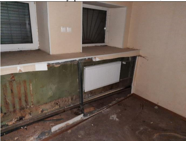
Фото № 19 – Внутреннее состояние помещения
