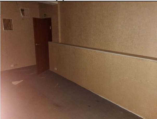
Фото № 27 – Внутреннее состояние помещения
