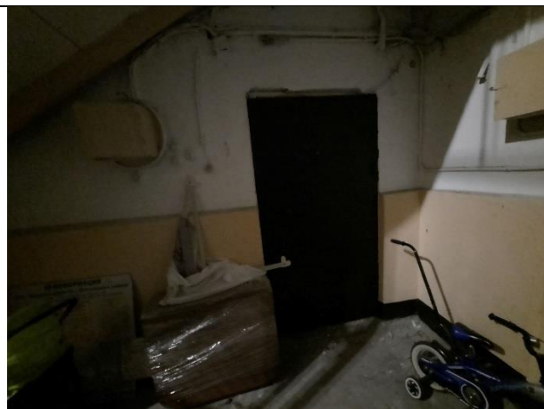
Фото № 32 – Внутреннее состояние помещения
