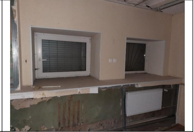
Фото № 18 – Внутреннее состояние помещения
