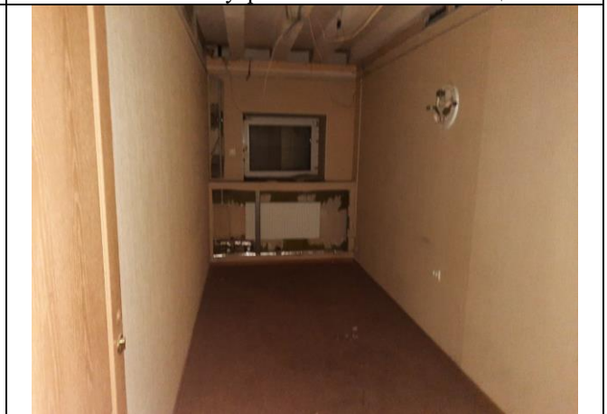
Фото № 20 – Внутреннее состояние помещения
