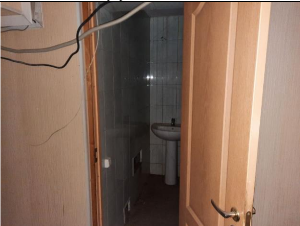
Фото № 21 – Внутреннее состояние помещения
