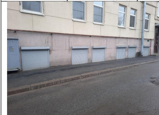
Фото № 9 – Окна помещения
