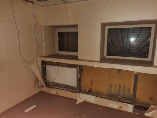
Фото № 25 – Внутреннее состояние помещения
