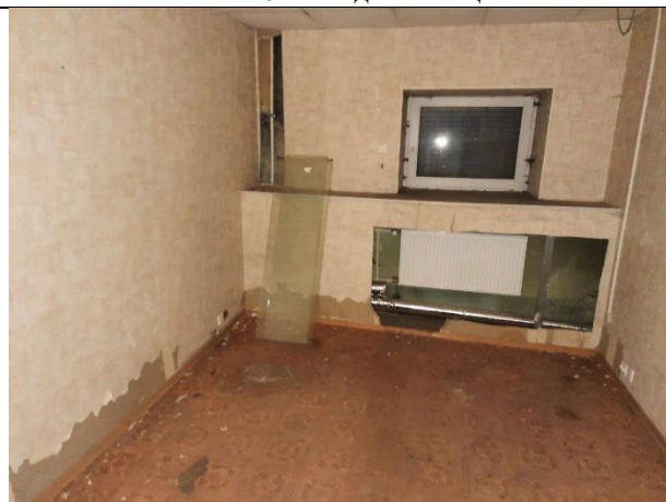
Фото № 12 – Внутреннее состояние помещения
