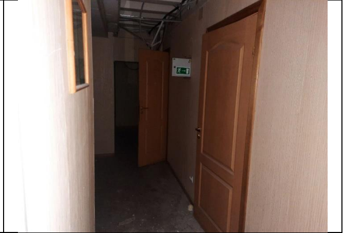
Фото № 16 – Внутреннее состояние помещения
