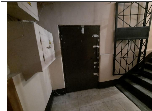
Фото № 11 – Вход в помещение
