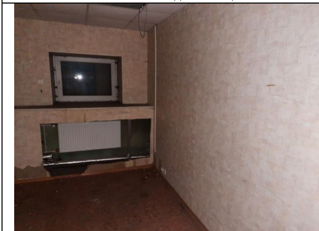
Фото № 13 – Внутреннее состояние помещения
