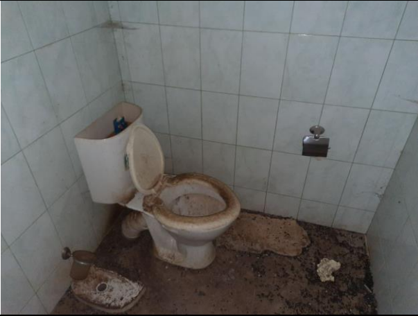
Фото № 23 – Внутреннее состояние помещения
