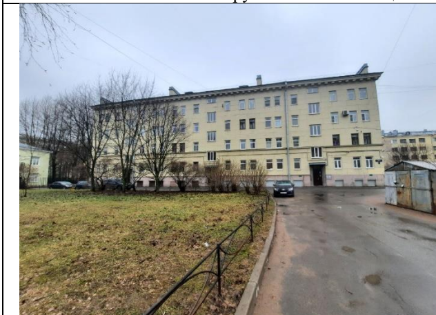
Фото № 5 – Здание, в котором находится Объект оценки
