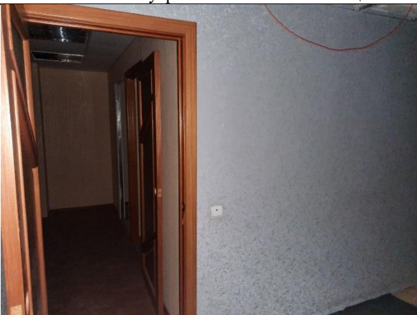
Фото № 29 – Внутреннее состояние помещения
