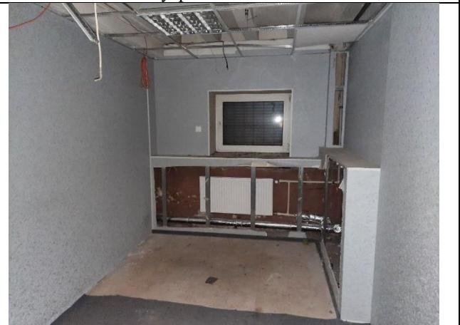
Фото № 28 – Внутреннее состояние помещения
