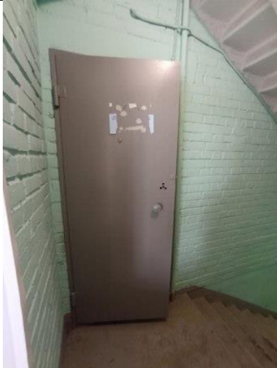
Фото № 7 – Вход в помещение
