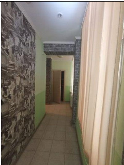
Фото № 11 – Внутреннее состояние помещения
