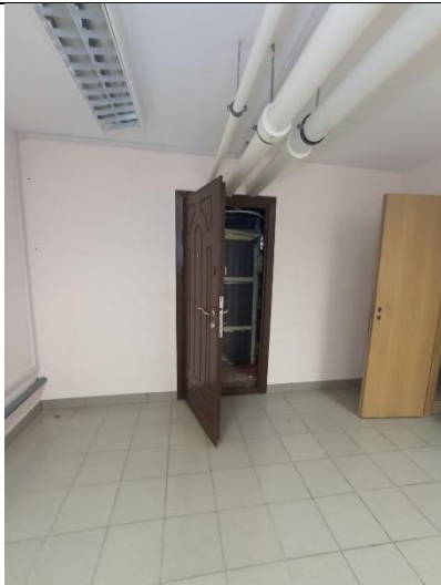
Фото № 9 – Внутреннее состояние помещения
