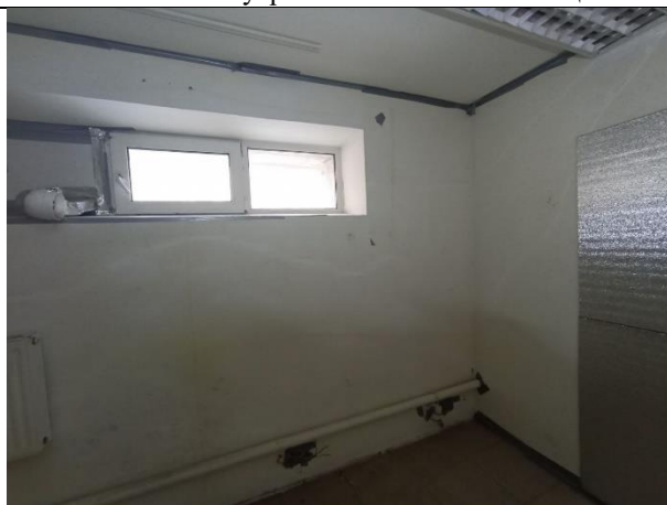
Фото № 19 – Внутреннее состояние помещения
