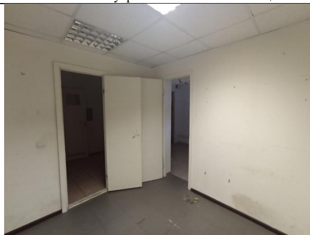
Фото № 20 – Внутреннее состояние помещения
