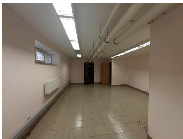
Фото № 8 – Внутреннее состояние помещения
