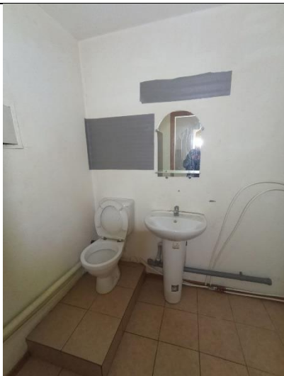
Фото № 17 – Внутреннее состояние помещения
