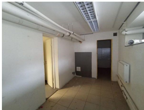
Фото № 18 – Внутреннее состояние помещения
