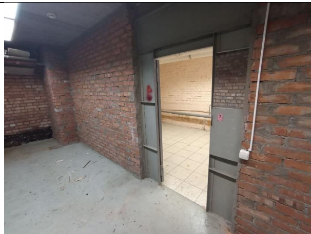
Фото № 6 – Вход в помещение
