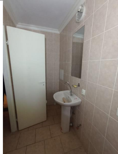
Фото № 14 – Внутреннее состояние помещения
