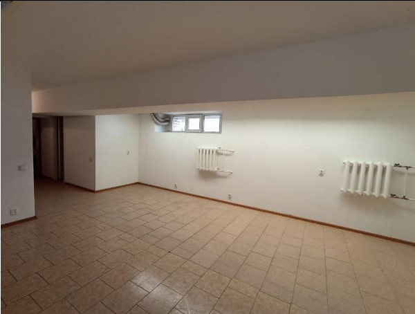
Фото № 15 – Внутреннее состояние помещения
