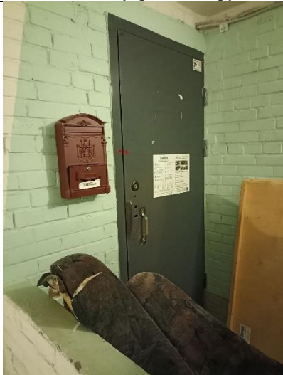
Фото № 7 – Вход в помещение
