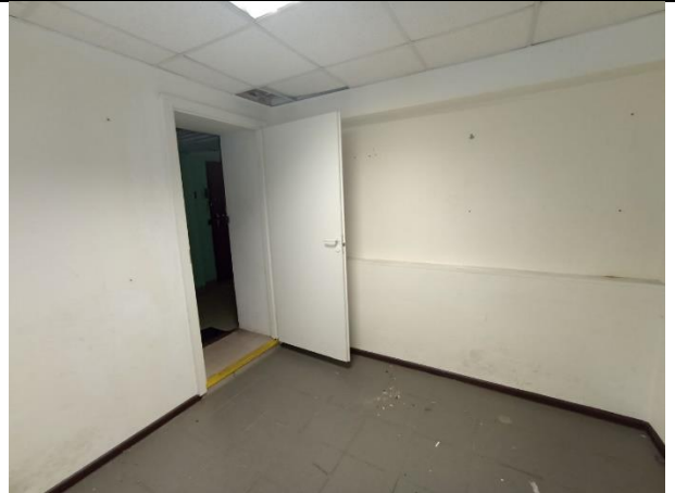
Фото № 16 – Внутреннее состояние помещения
