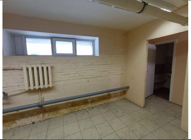
Фото № 12 – Внутреннее состояние помещения
