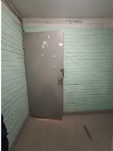
Фото № 13 – Вход в помещение
