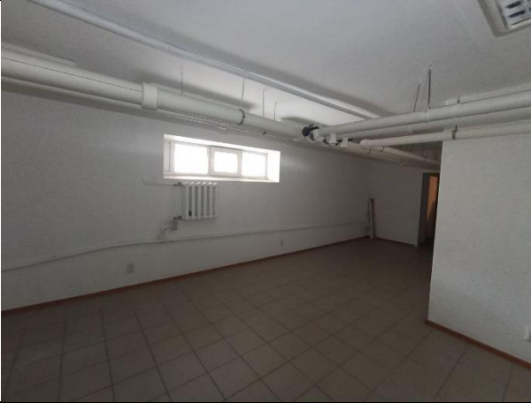
Фото № 11 – Внутреннее состояние помещения
