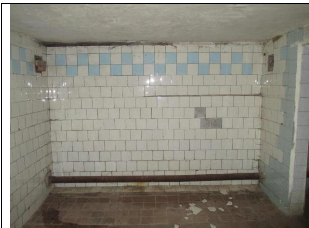
Фото № 31 – Внутреннее состояние помещения
