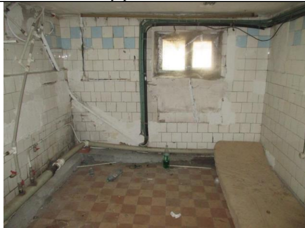
Фото № 19 – Внутреннее состояние помещения
