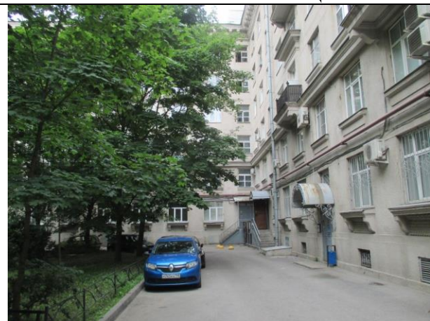
Фото № 1 – Ближайшее окружение и подъездные пути
