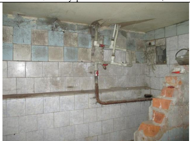
Фото № 34 – Внутреннее состояние помещения
