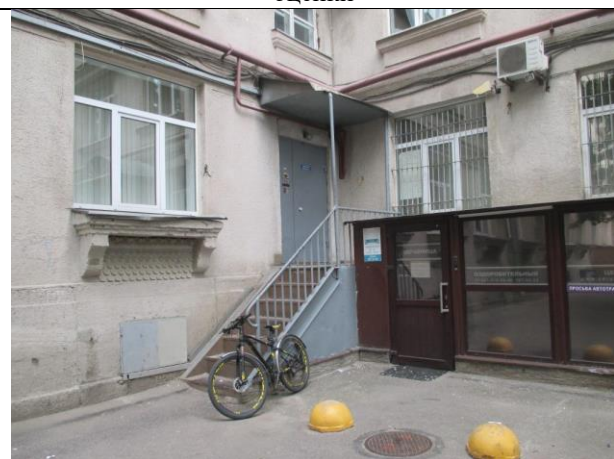
Фото № 5 – Общий вход в помещение
