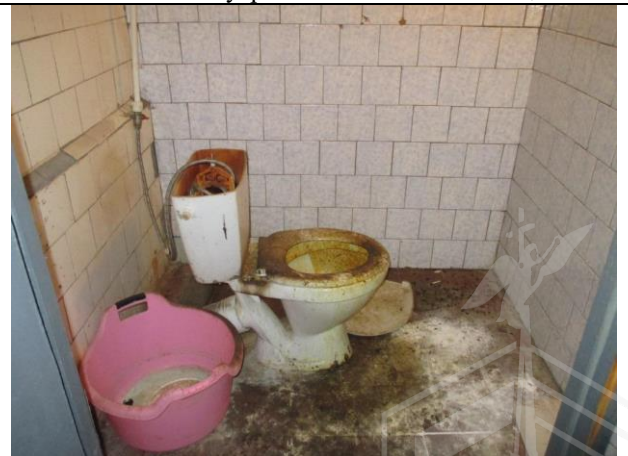
Фото № 22 – Внутреннее состояние помещения
