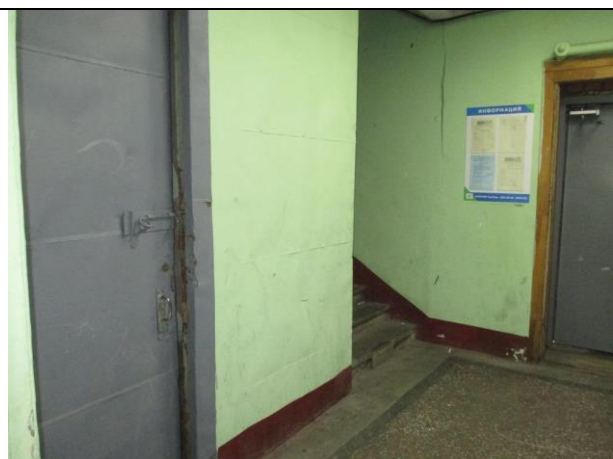
Фото № 6 – Проход к помещению (через парадную)
