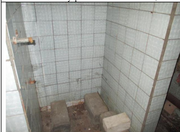
Фото № 25 – Внутреннее состояние помещения
