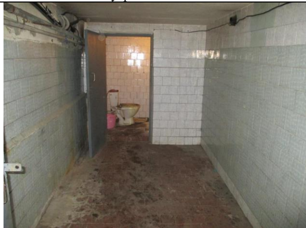
Фото № 21 – Внутреннее состояние помещения
