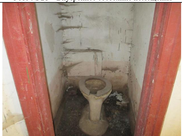
Фото № 28 – Внутреннее состояние помещения
