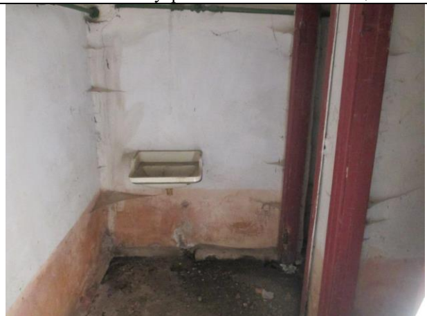
Фото № 26 – Внутреннее состояние помещения
