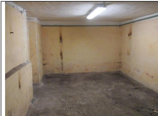
Фото № 23 – Внутреннее состояние помещения
