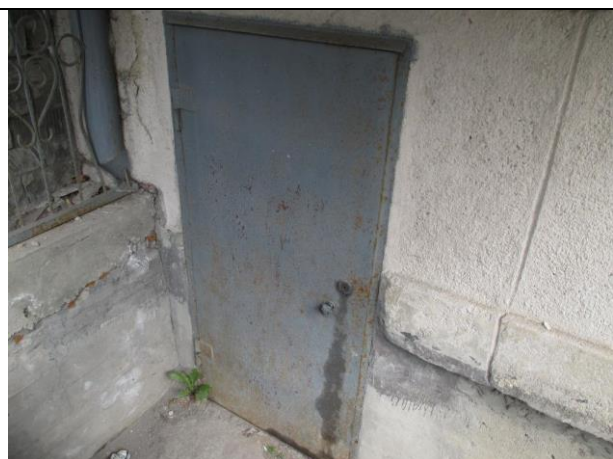
Фото № 6 – Вход в подвал
