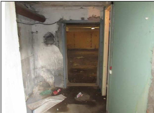
Фото № 7 – Проход к помещению
