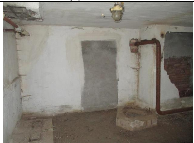
Фото № 18 – Внутреннее состояние помещения
