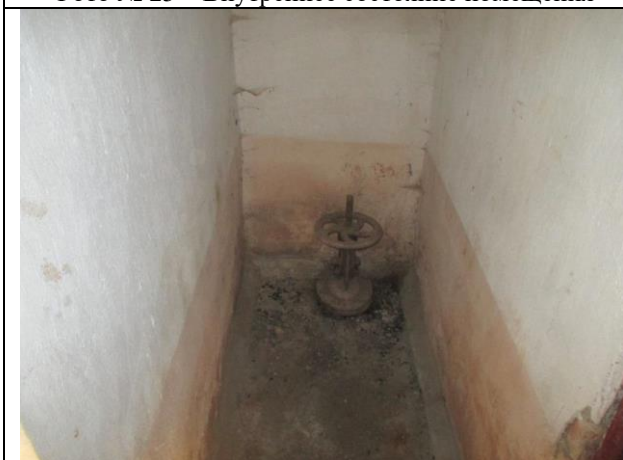
Фото № 27 – Внутреннее состояние помещения
