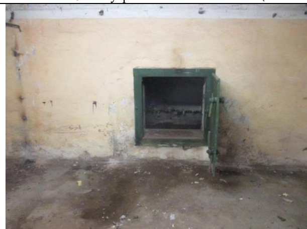
Фото № 10 – Внутреннее состояние помещения
