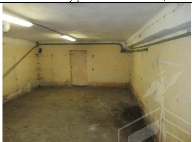
Фото № 30 – Внутреннее состояние помещения
