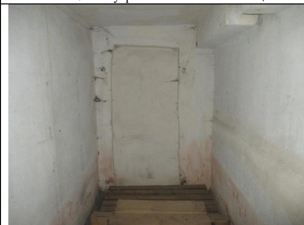
Фото № 21 – Внутреннее состояние помещения
