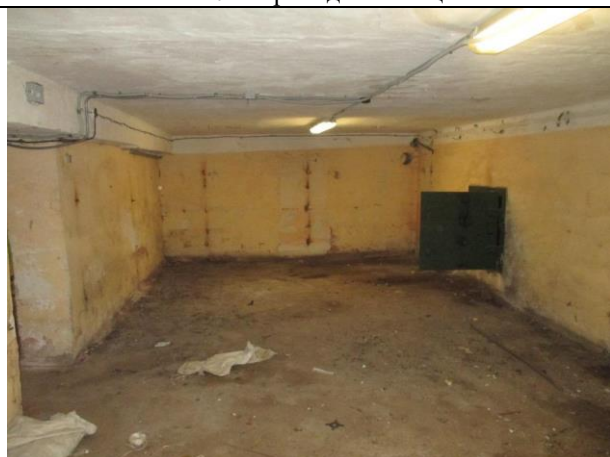
Фото № 9 – Внутреннее состояние помещения
