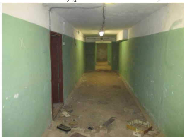
Фото № 13 – Внутреннее состояние помещения
