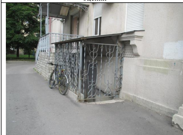
Фото № 5 – Прямок, где расположен общий вход в подвал
