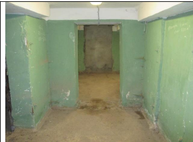
Фото № 15 – Внутреннее состояние помещения
