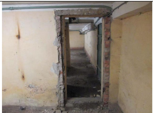
Фото № 24 – Внутреннее состояние помещения
