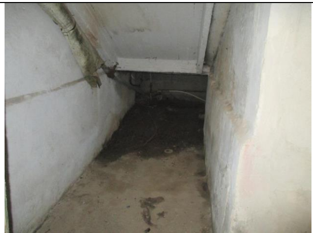
Фото № 16 – Внутреннее состояние помещения
