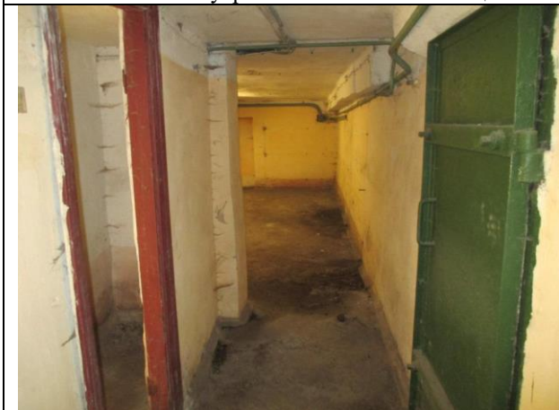
Фото № 25 – Внутреннее состояние помещения
