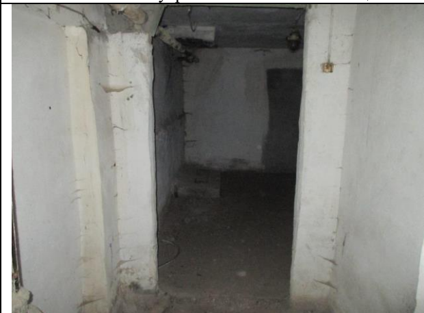
Фото № 17 – Внутреннее состояние помещения
