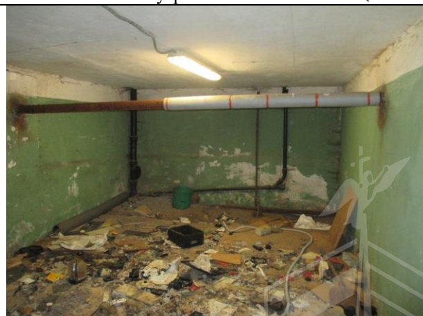
Фото № 14 – Внутреннее состояние помещения
