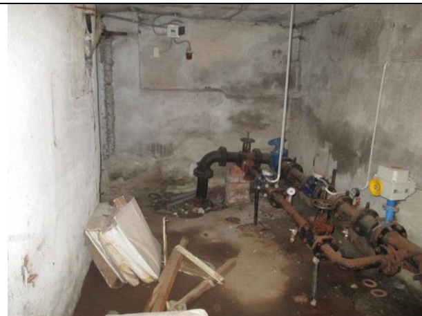
Фото № 8 – Внутреннее состояние помещения
