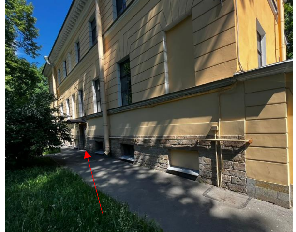
Фото 8. Общий вход с улицы Объекта оценки
