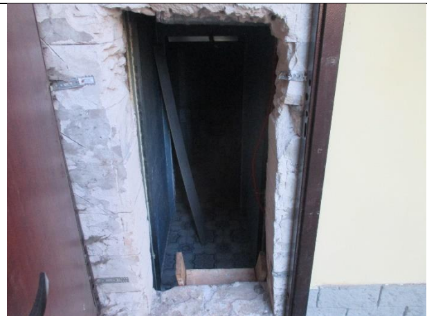
Фото № 8 – Вход в помещение
