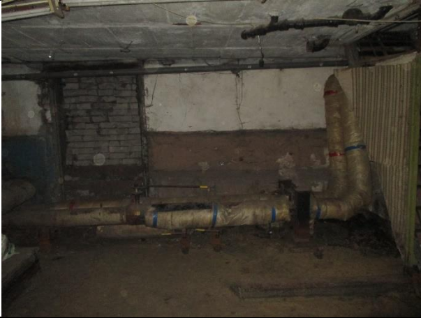
Фото № 15 – Внутреннее состояние помещения
