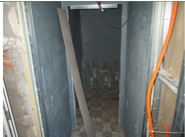
Фото № 10 – Внутреннее состояние помещения
