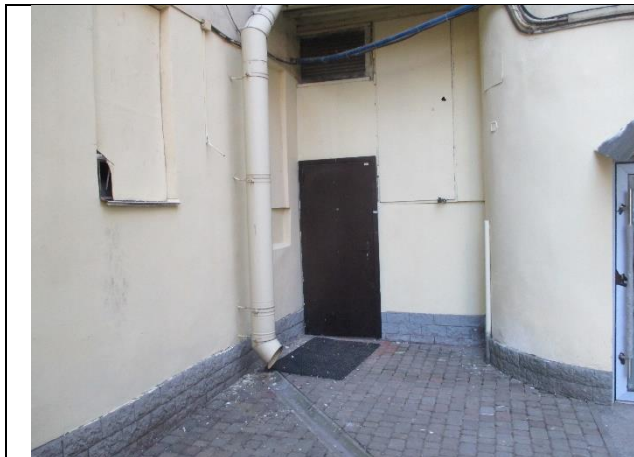
Фото № 7 – Вход в помещение
