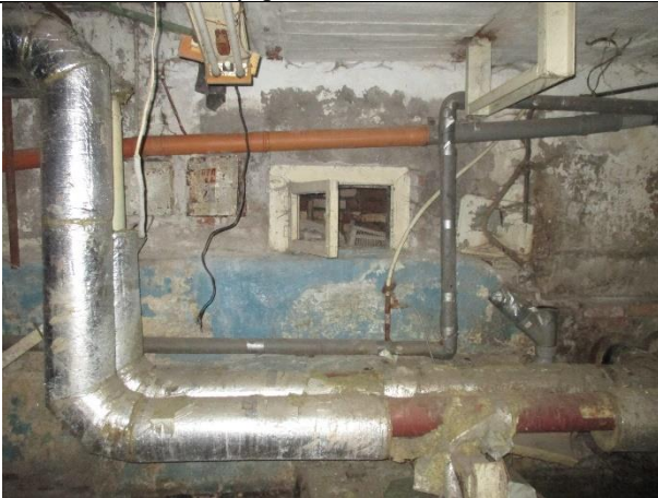
Фото № 25 – Внутреннее состояние помещения
