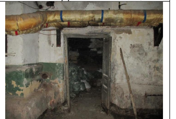
Фото № 20 – Внутреннее состояние помещения
