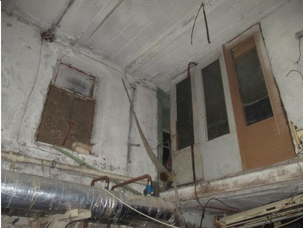
Фото № 17 – Внутреннее состояние помещения
