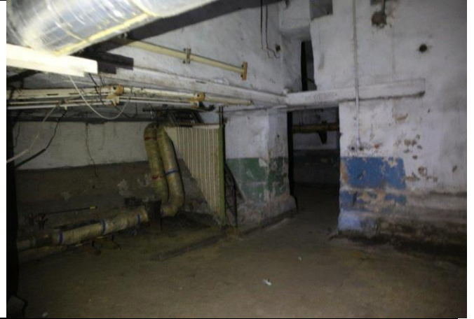
Фото № 16 – Внутреннее состояние помещения
