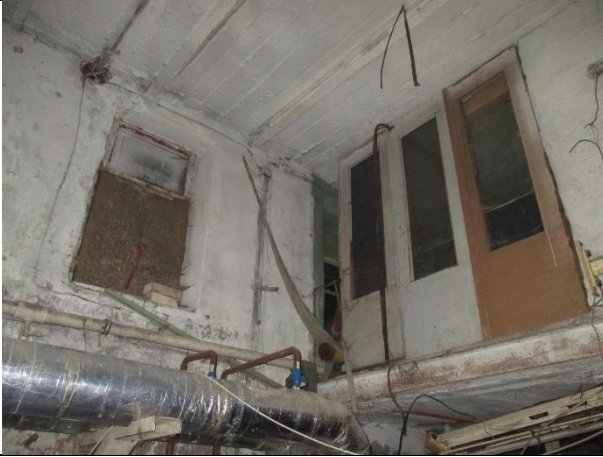
Фото № 17 – Внутреннее состояние помещения
