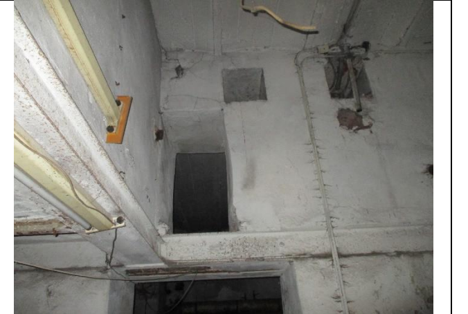
Фото № 18 – Внутреннее состояние помещения
