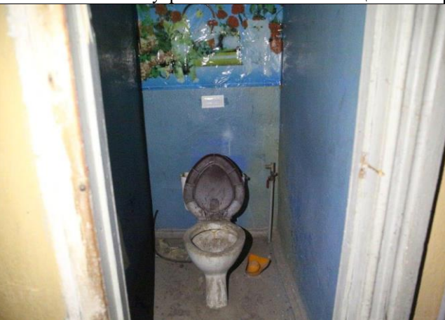
Фото № 29 – Внутреннее состояние помещения
