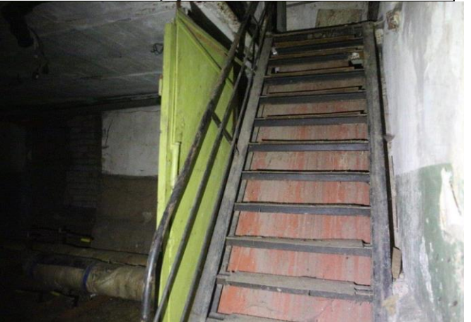
Фото № 26 – Внутреннее состояние помещения
