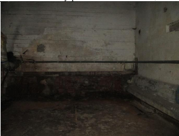
Фото № 19 – Внутреннее состояние помещения
