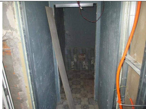
Фото № 10 – Внутреннее состояние помещения
