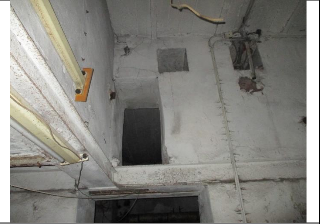
Фото № 18 – Внутреннее состояние помещения
