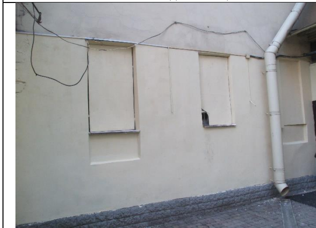
Фото № 9 – Окна помещения
