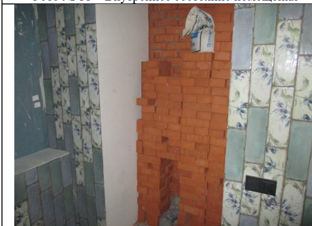
Фото № 13 – Внутреннее состояние помещения
