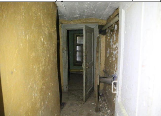
Фото № 27 – Внутреннее состояние помещения
