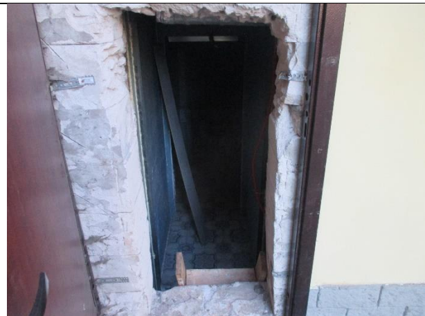
Фото № 8 – Вход в помещение
