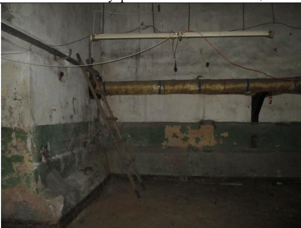
Фото № 21 – Внутреннее состояние помещения
