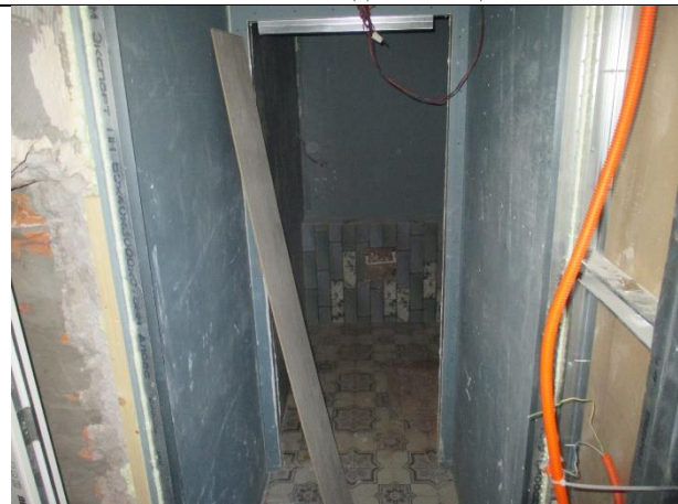
Фото № 10 – Внутреннее состояние помещения
