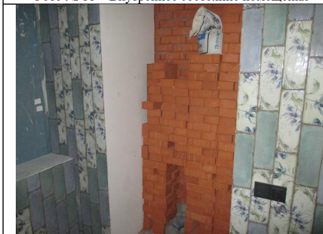
Фото № 13 – Внутреннее состояние помещения
