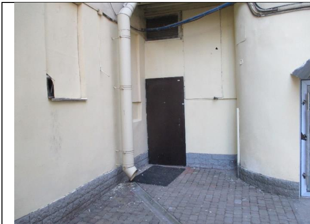
Фото № 7 – Вход в помещение
