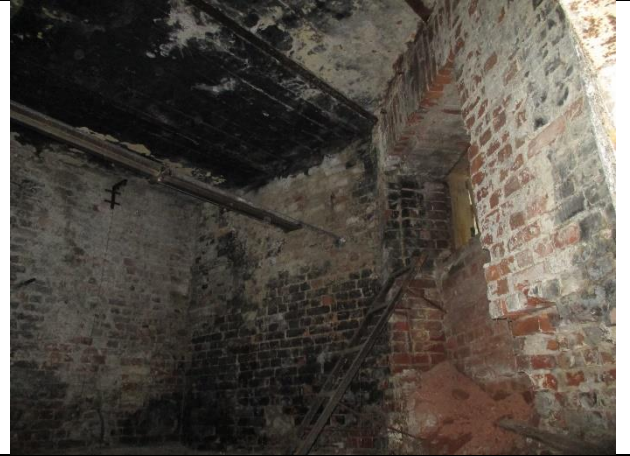
Фото № 24 – Внутреннее состояние помещения
