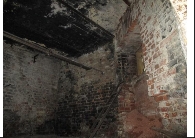
Фото № 24 – Внутреннее состояние помещения
