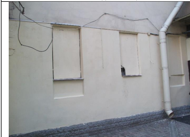
Фото № 9 – Окна помещения
