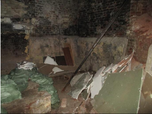
Фото № 23 – Внутреннее состояние помещения
