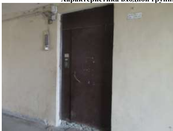
Фото 5. Общий вход со двора (из арки)
