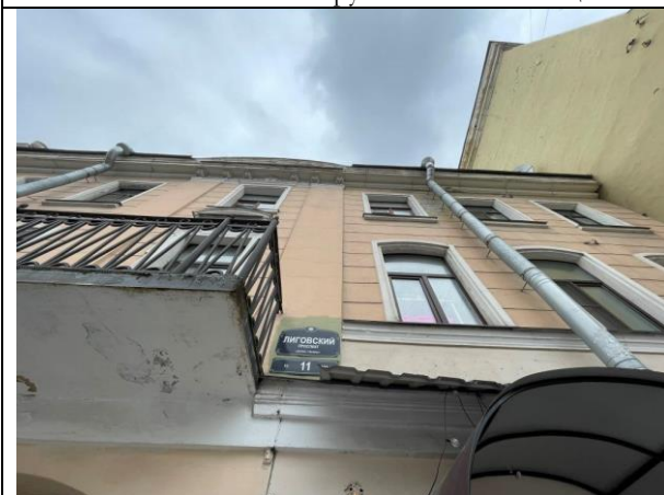
Фото 13. Адрес Объекта оценки
