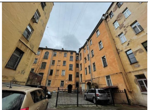
Фото 18. Внутривдворовая территория Объекта оценки
