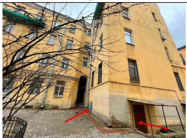
Фото 20. Вид здания расположения Объекта оценки, входная и оконная группа Объекта оценки
