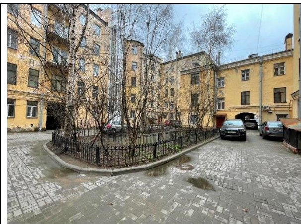
Фото 17. Внутривдворовая территория Объекта оценки
