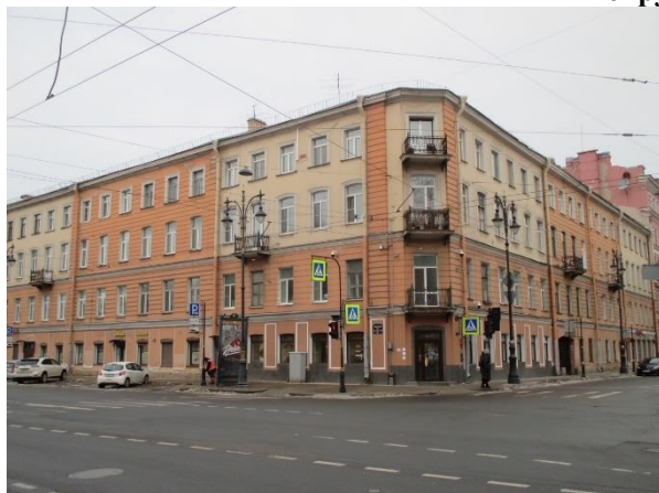
Фото 1. Вид здания, в котором расположен Объект оценки
