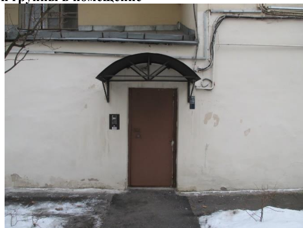
Фото 4. Общий вход со двора
