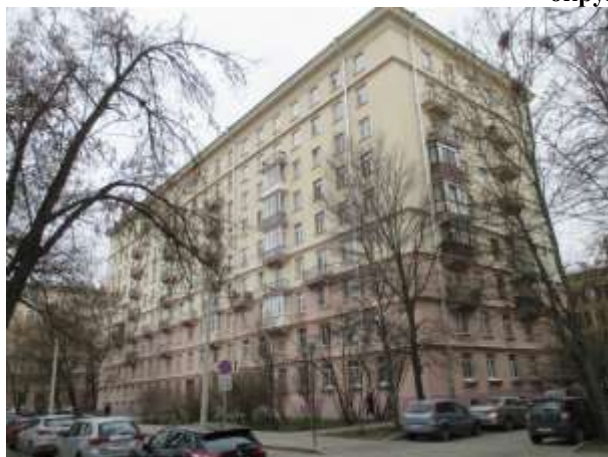
Фото 1. Вид здания, в котором расположен Объект оценки
