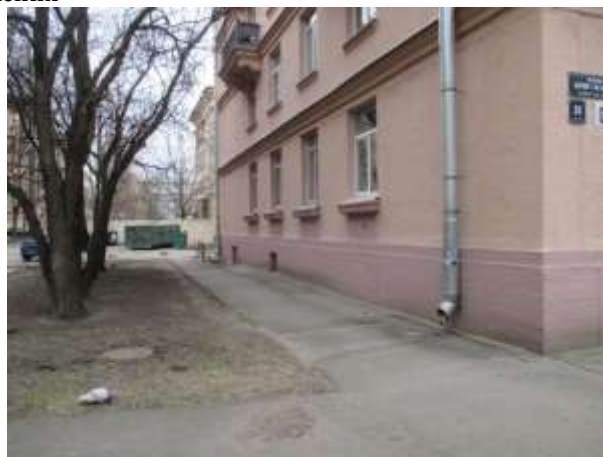
Фото 2. Вид здания, в котором расположен Объект оценки
