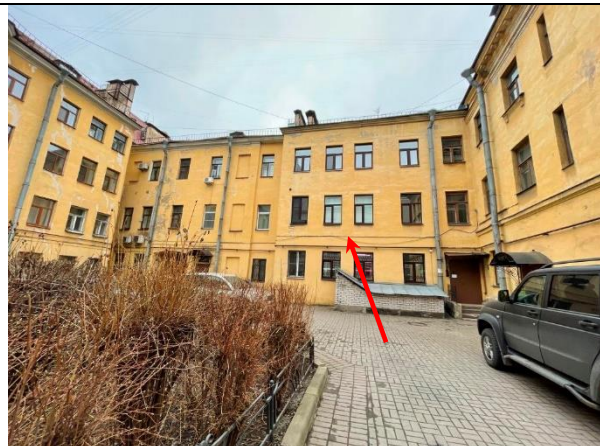
Фото 17. Вид здания расположения Объекта оценки
