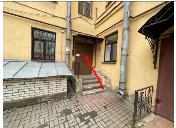
Фото 18. Входная группа Объекта оценки (общий вход со двора)
