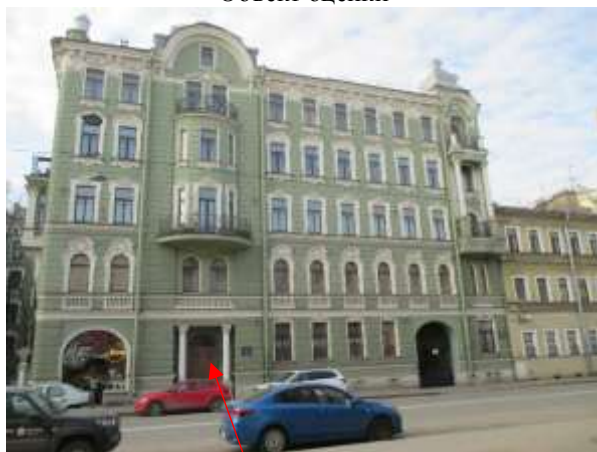
Фото 3. Вид здания, в котором расположен Объект оценки
