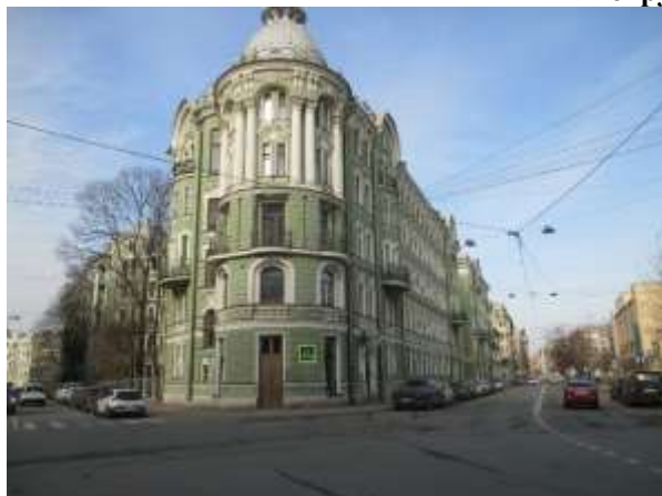
Фото 1. Вид здания, в котором расположен Объект оценки
