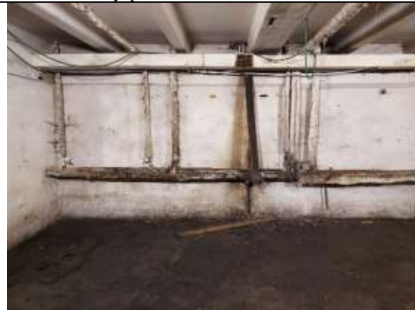
Фото 9. Внутреннее состояние Объекта оценки
