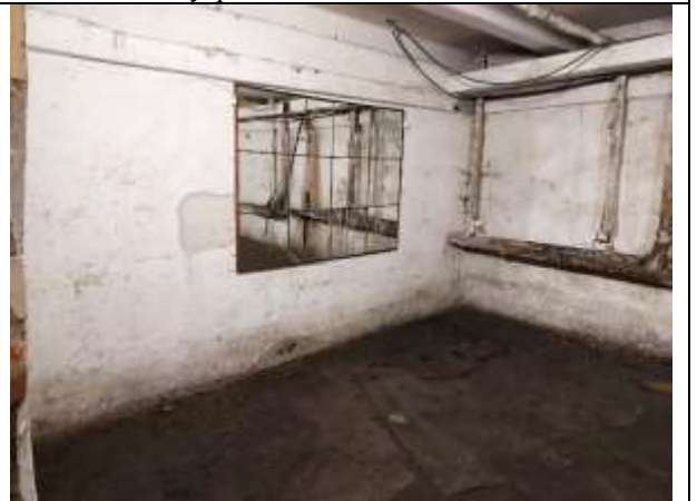
Фото 10. Внутреннее состояние Объекта оценки
