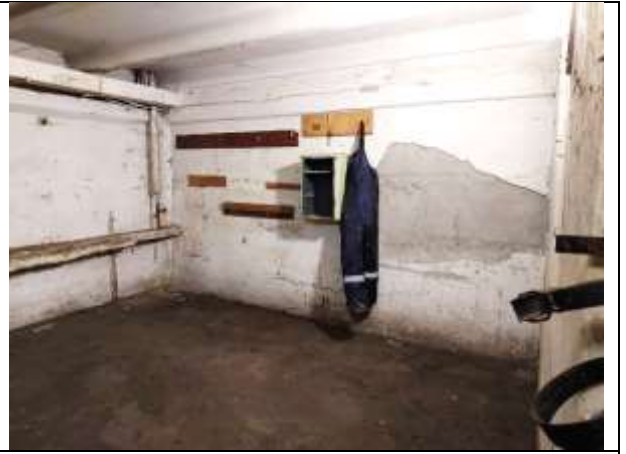
Фото 8. Внутреннее состояние Объекта оценки
