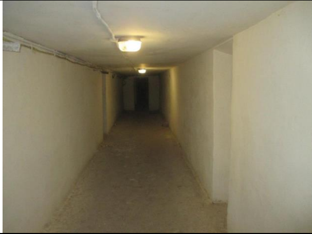
Фото № 23 – Внутреннее состояние помещения
