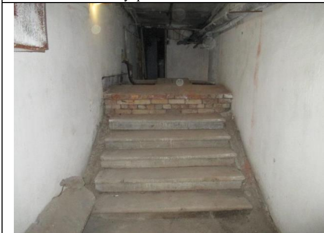
Фото № 33 – Внутреннее состояние помещения
