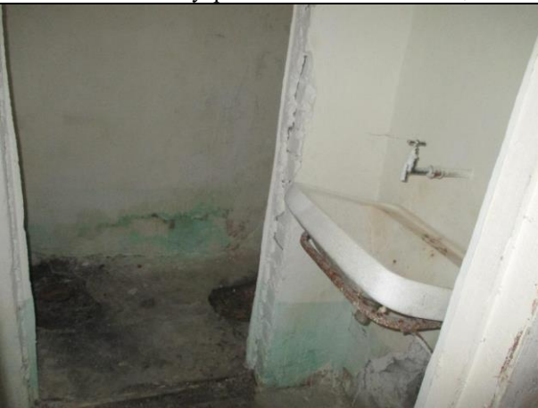
Фото № 19 – Внутреннее состояние помещения
