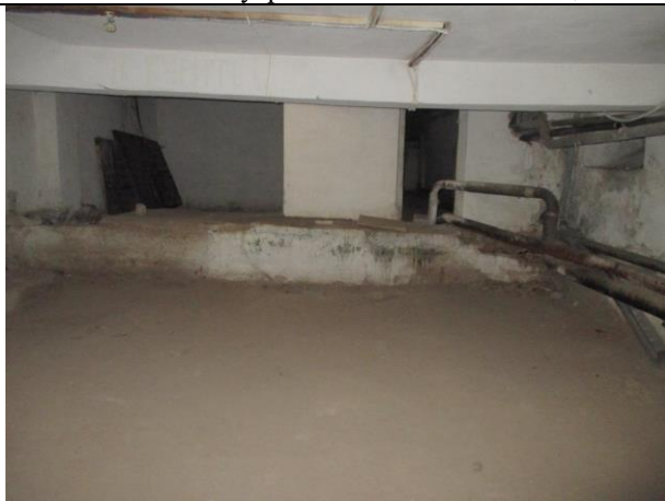
Фото № 27 – Внутреннее состояние помещения
