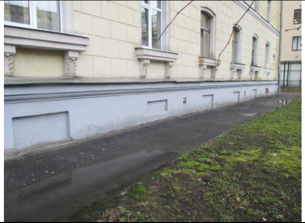
Фото № 8 – Окна помещения
