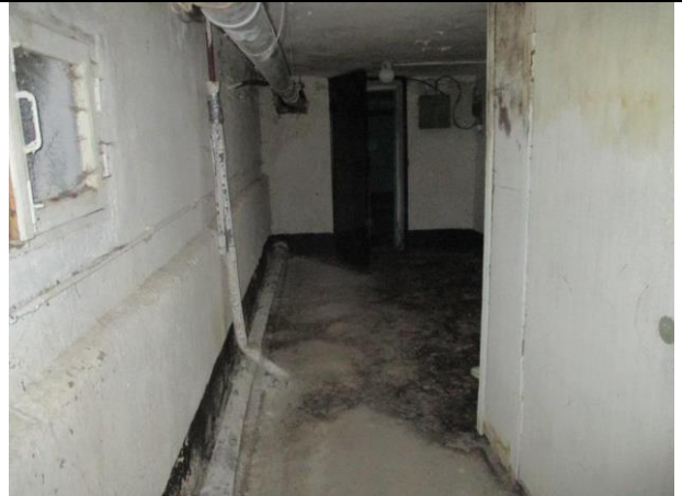
Фото № 12 – Внутреннее состояние помещения
