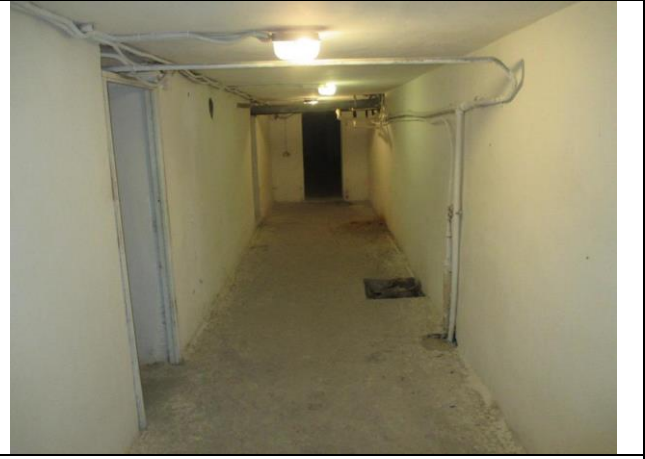
Фото № 16 – Внутреннее состояние помещения
