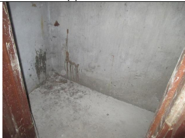
Фото № 34 – Внутреннее состояние помещения
