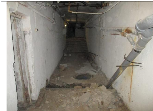
Фото № 31 – Внутреннее состояние помещения
