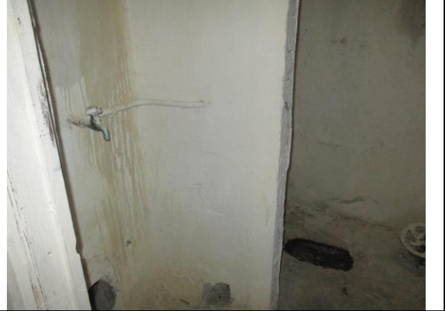
Фото № 18 – Внутреннее состояние помещения
