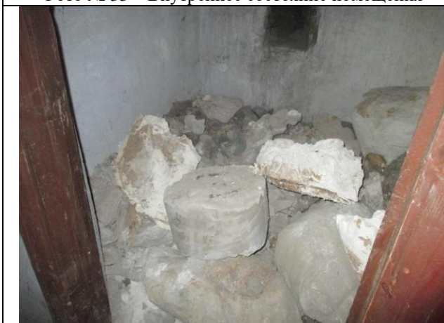
Фото № 35 – Внутреннее состояние помещения
