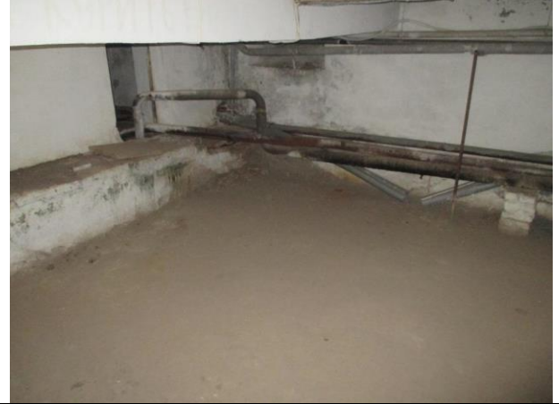
Фото № 26 – Внутреннее состояние помещения
