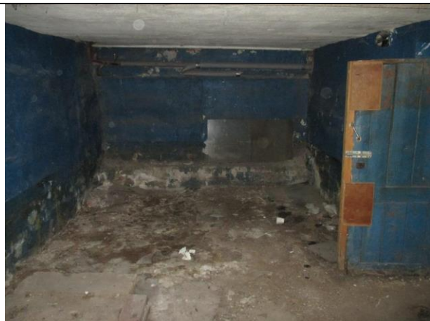
Фото № 40 – Внутреннее состояние помещения
