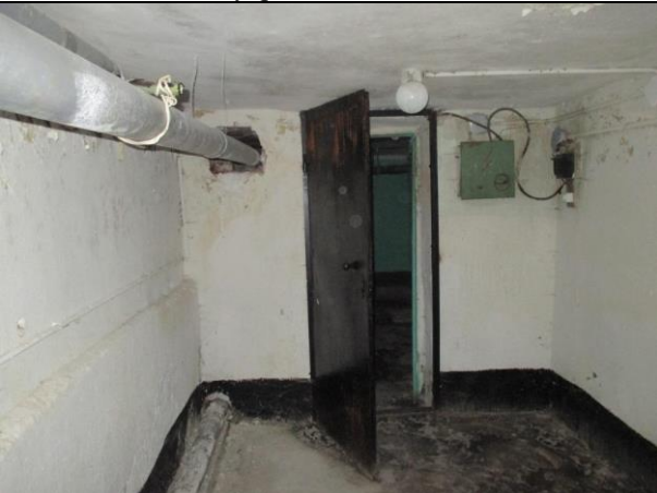
Фото № 13 – Внутреннее состояние помещения
