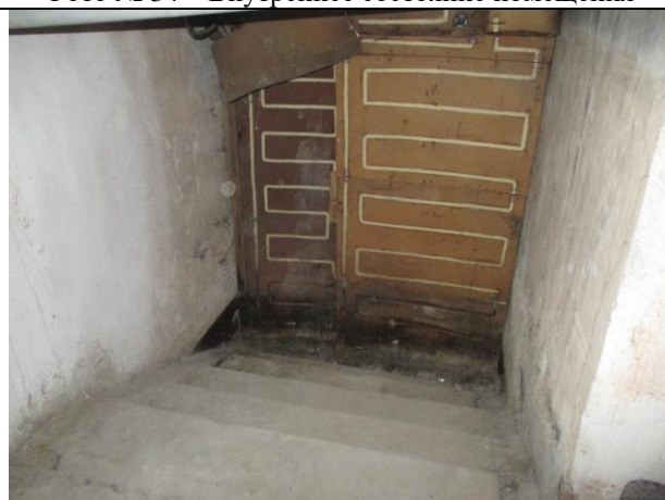
Фото № 36 – Внутреннее состояние помещения
