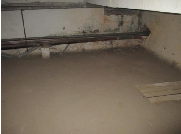
Фото № 25 – Внутреннее состояние помещения
