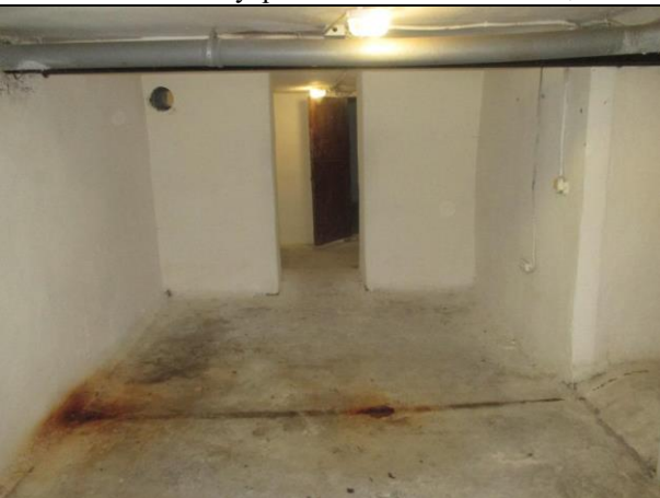
Фото № 21 – Внутреннее состояние помещения
