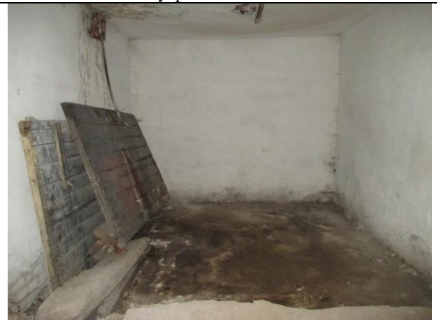
Фото № 28 – Внутреннее состояние помещения
