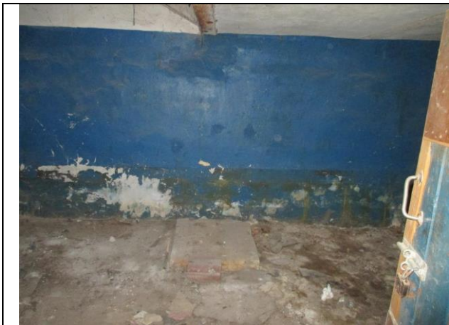
Фото № 39 – Внутреннее состояние помещения
