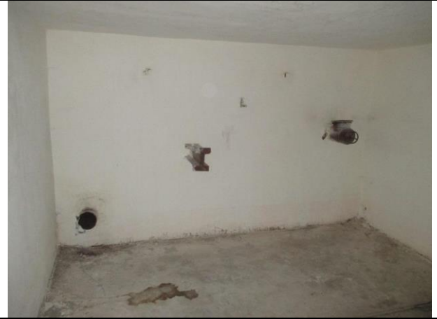
Фото № 24 – Внутреннее состояние помещения
