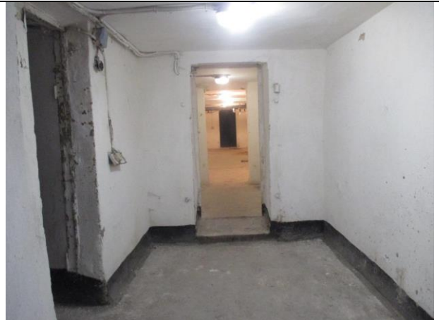
Фото № 10 – Внутреннее состояние помещения
