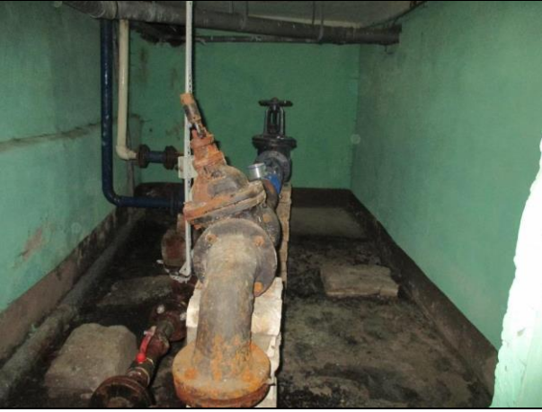
Фото № 15 – Внутреннее состояние помещения
