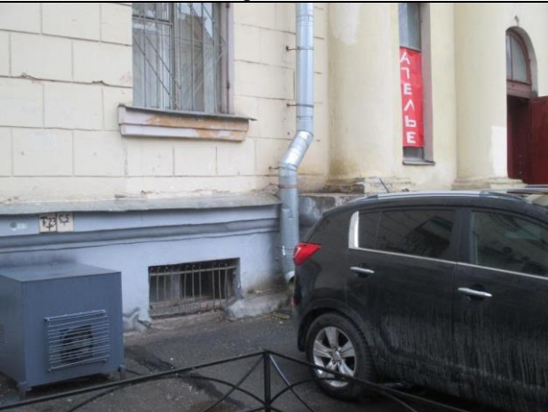
Фото № 9 – Окна помещения
