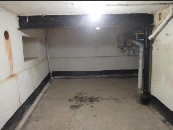
Фото № 11 – Внутреннее состояние помещения
