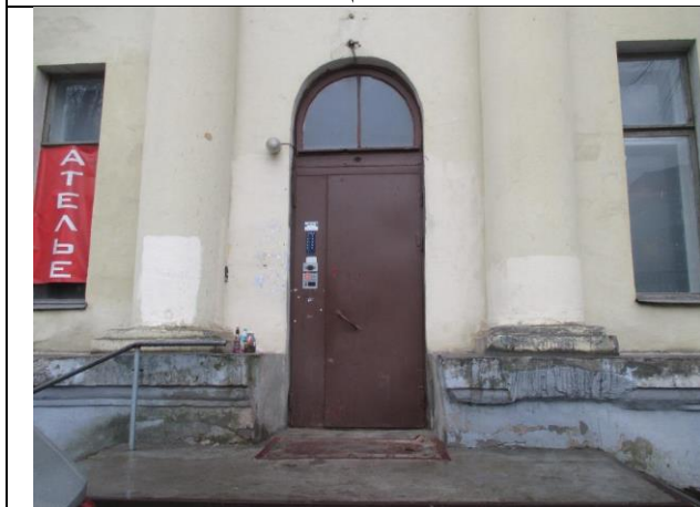
Фото № 3 – Общий вход в помещение со двора
