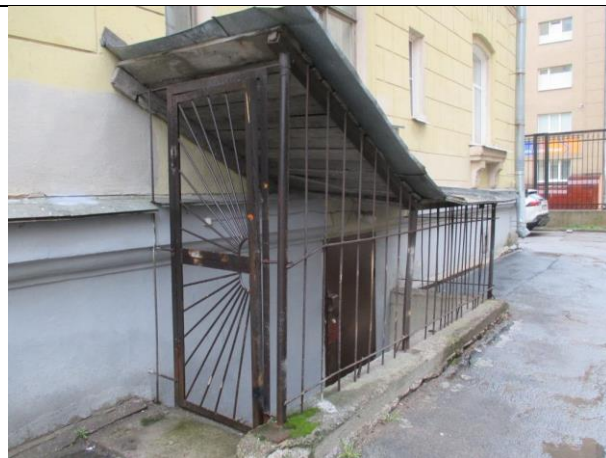
Фото № 4 – Отдельный вход в помещение через приямок
