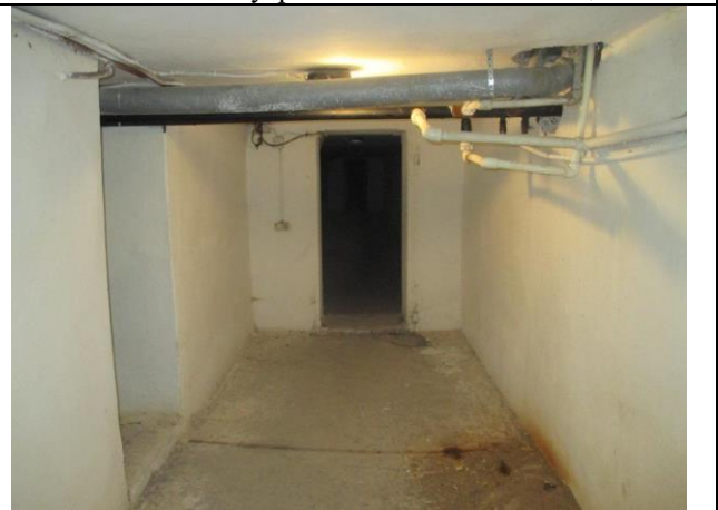
Фото № 20 – Внутреннее состояние помещения
