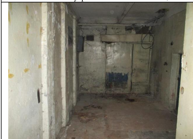
Фото № 37 – Внутреннее состояние помещения
