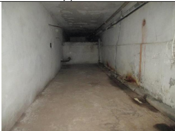
Фото № 29 – Внутреннее состояние помещения
