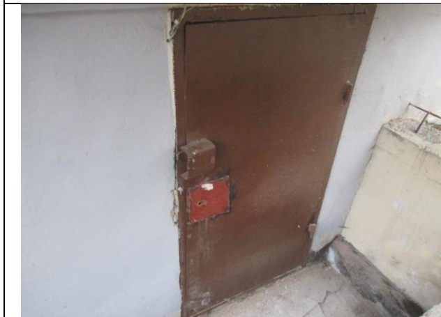
Фото № 5 – Отдельный вход в помещение через приямок
