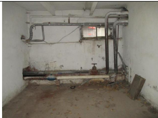
Фото № 32 – Внутреннее состояние помещения
