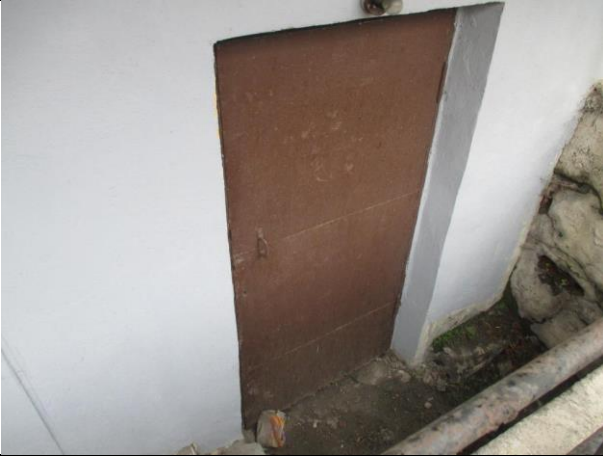
Фото № 7 – Отдельный вход в помещение через приямок
