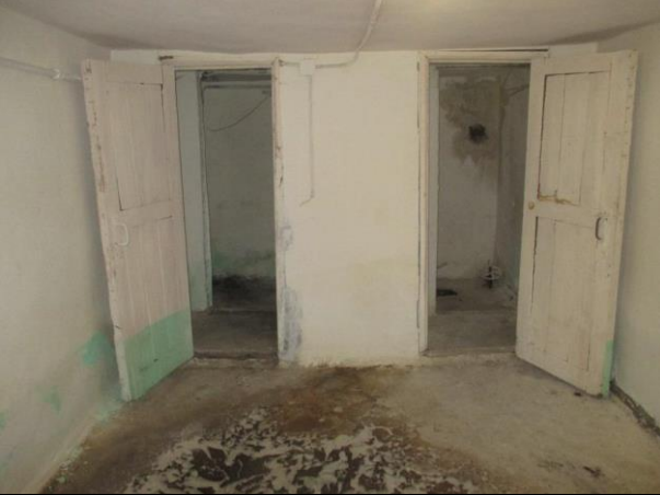
Фото № 17 – Внутреннее состояние помещения
