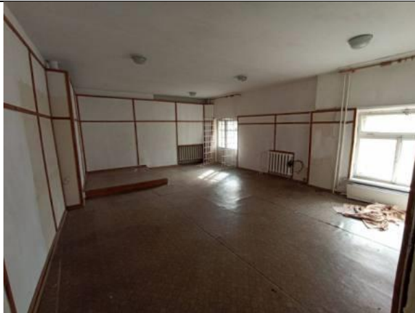
Фото № 17 – Внутреннее состояние помещения
