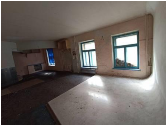
Фото № 7 – Внутреннее состояние помещения
