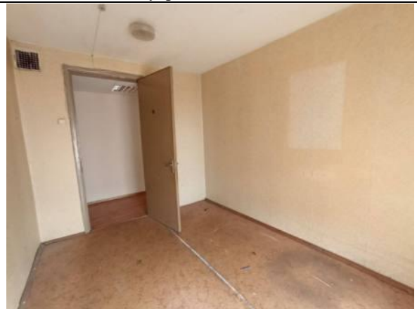
Фото № 12 – Внутреннее состояние помещения
