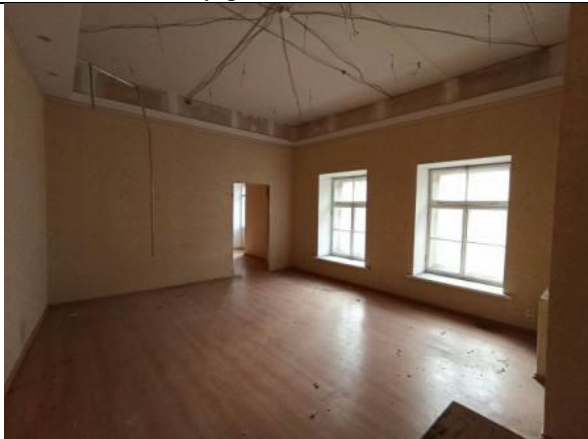
Фото № 11 – Внутреннее состояние помещения
