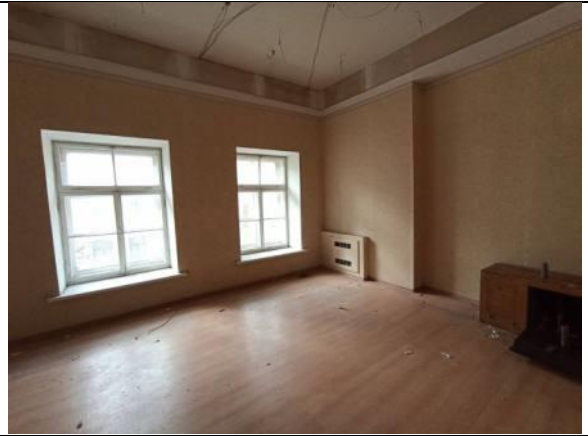
Фото № 8 – Внутреннее состояние помещения
