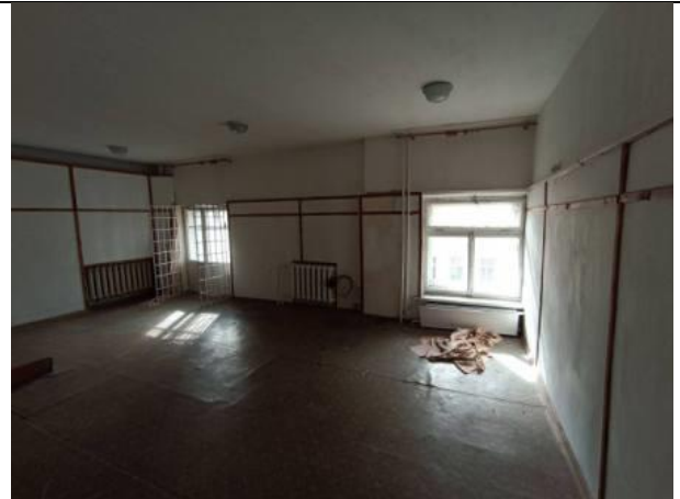
Фото № 18 – Внутреннее состояние помещения
