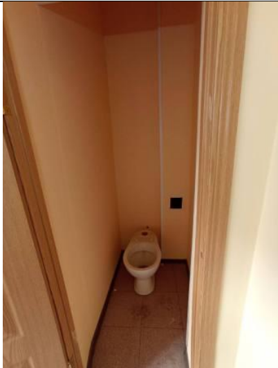
Фото № 15 – Внутреннее состояние помещения
