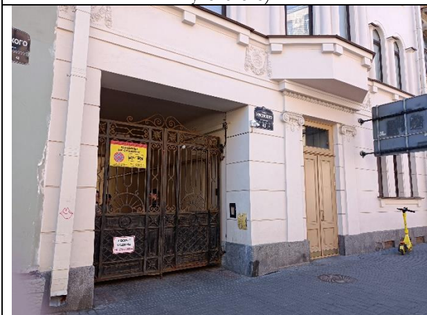
Фото 5. Вид здания Объекта оценки
