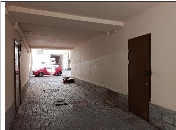
Фото 9. Входная группа Объекта оценки (Вход со двора через арку)
