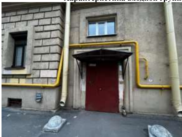
Фото 3. Общий вход со двора
