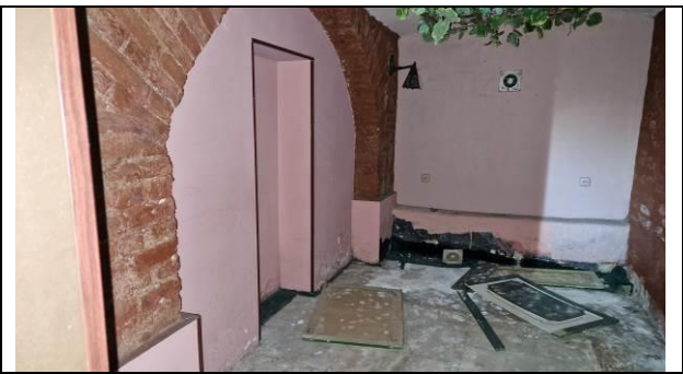
Фото 30. Типичное состояние Объекта оценки
