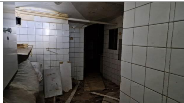
Фото 35. Типичное состояние Объекта оценки
