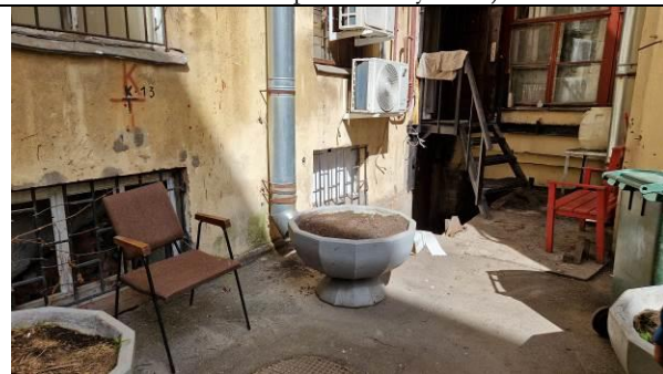
Фото 27. Вход со двора
