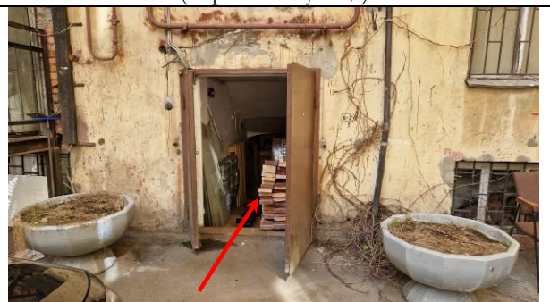
Фото 26. Вход со двора
