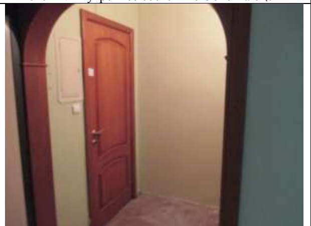
Фото 16. Внутреннее состояние Объекта оценки
