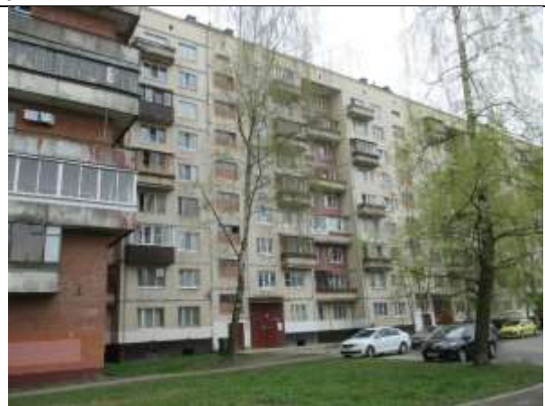
Фото 2. Вид здания, в котором расположен Объект оценки
