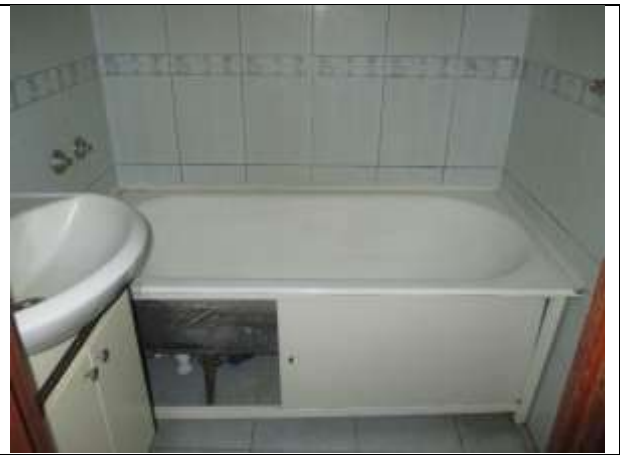
Фото 12. Внутреннее состояние Объекта оценки
