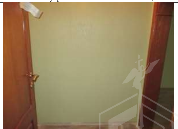
Фото 18. Внутреннее состояние Объекта оценки
