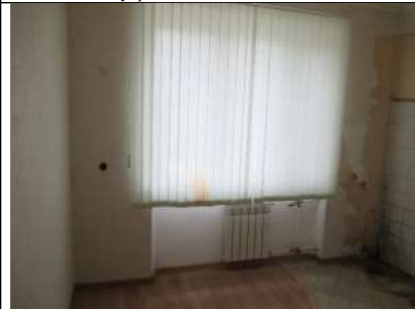
Фото 13. Внутреннее состояние Объекта оценки
