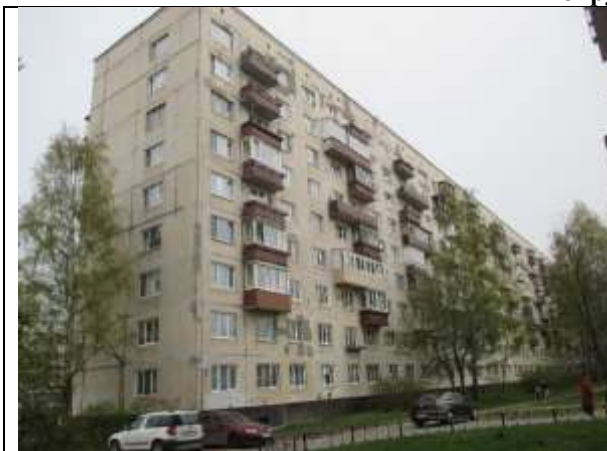
Фото 1. Вид здания, в котором расположен Объект оценки
