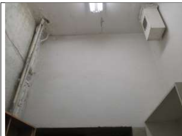
Фото 9. Внутреннее состояние Объекта оценки
