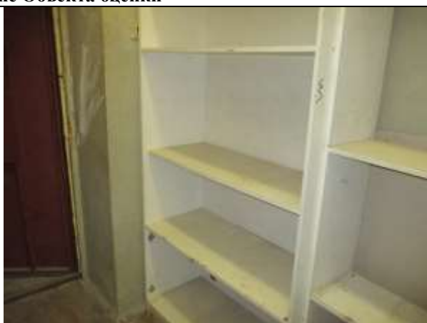
Фото 6. Внутреннее состояние Объекта оценки
