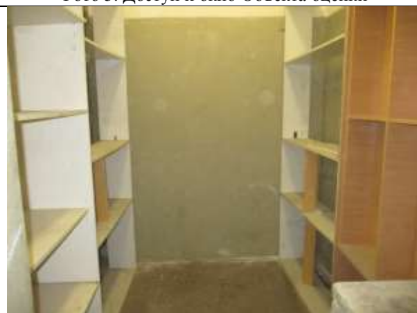
Фото 7. Внутреннее состояние Объекта оценки
