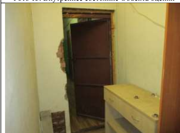
Фото 15. Внутреннее состояние Объекта оценки
