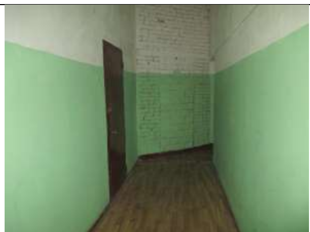
Фото 18. Внутреннее состояние Объекта оценки
