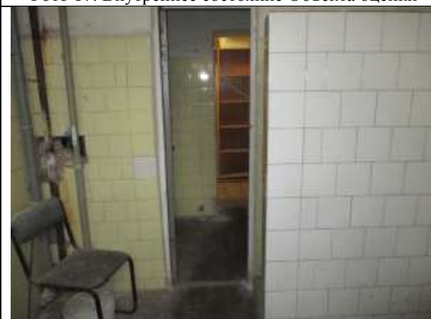
Фото 19. Внутреннее состояние Объекта оценки
