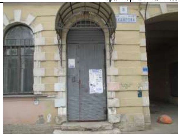
Фото 3. Общий вход с улицы
