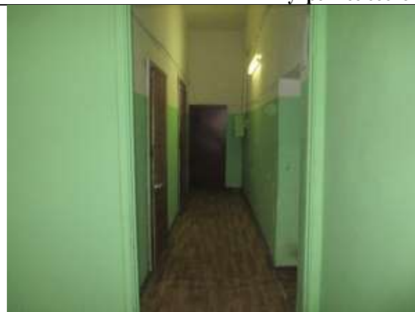
Фото 7. Внутреннее состояние Объекта оценки
