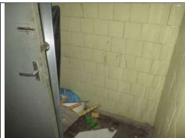
Фото 17. Внутреннее состояние Объекта оценки
