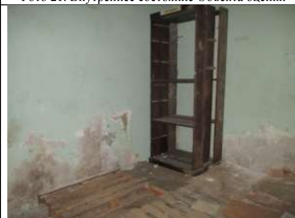
Фото 23. Внутреннее состояние Объекта оценки
