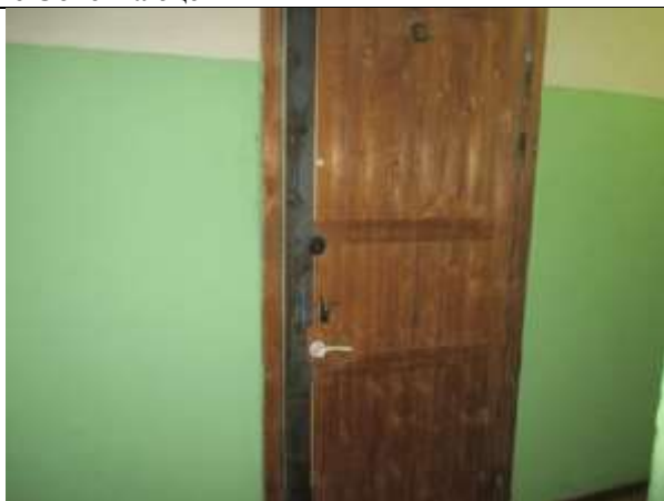
Фото 8. Внутреннее состояние Объекта оценки
