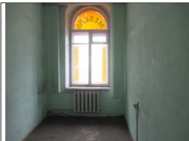
Фото 9. Внутреннее состояние Объекта оценки
