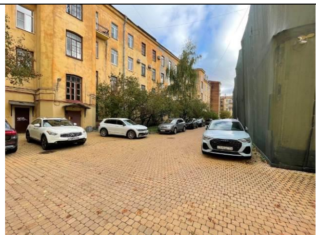
Фото 16. Внутривдворовая территория Объекта оценки
