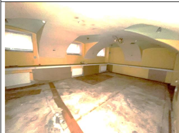
Фото 33. Типичное состояние Объекта оценки
