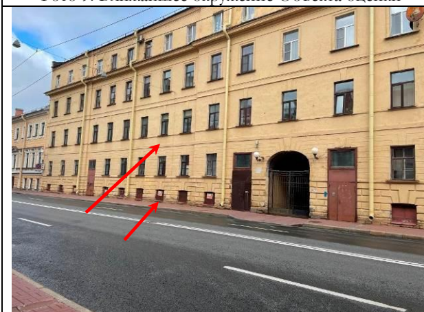
Фото 11. Вид здания Объекта оценки, оконная группа Объекта оценки
