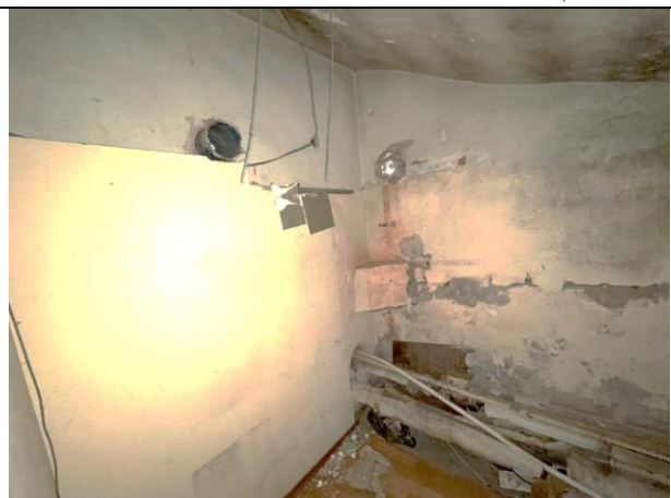
Фото 28. Типичное состояние Объекта оценки
