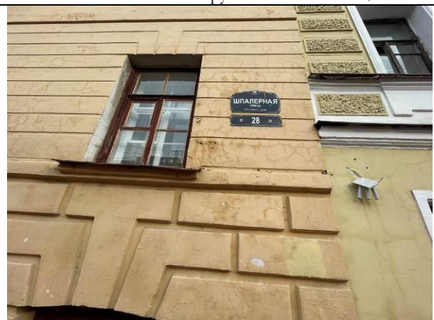
Фото 10. Адрес Объекта оценки
