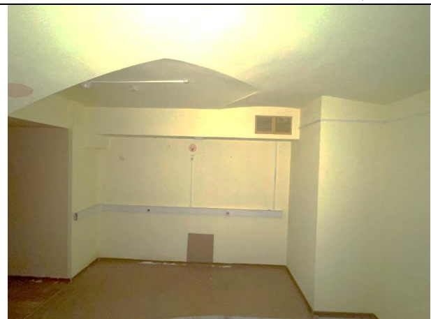
Фото 42. Типичное состояние Объекта оценки
