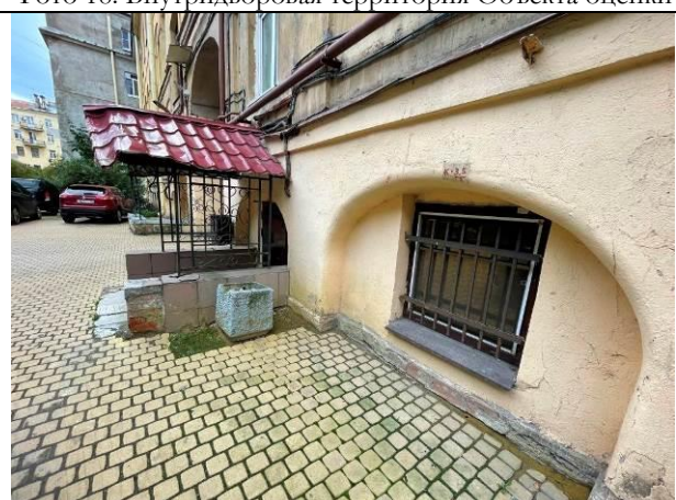
Фото 20. Оконная и входная группа Объекта оценки
