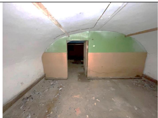
Фото 40. Типичное состояние Объекта оценки
