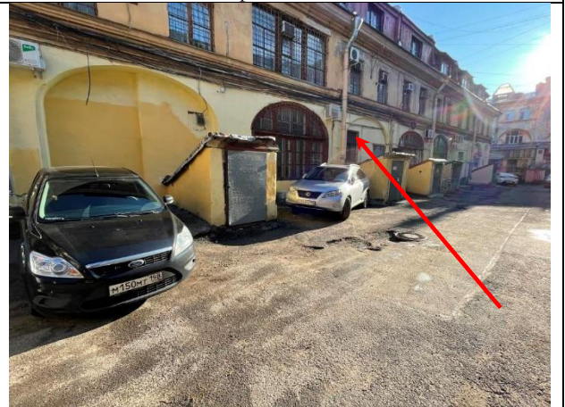
Фото 18. Вид здания расположения Объекта оценки (внутридворовая территория Объекта оценки)
