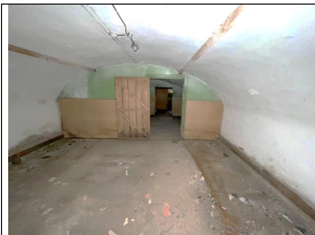
Фото 39. Типичное состояние Объекта оценки
