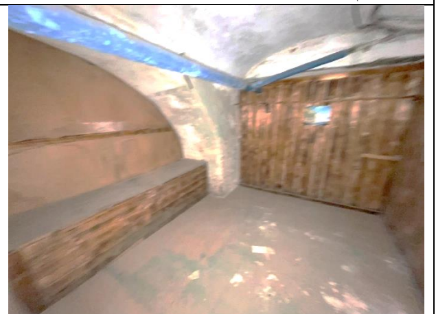
Фото 44. Типичное состояние Объекта оценки
