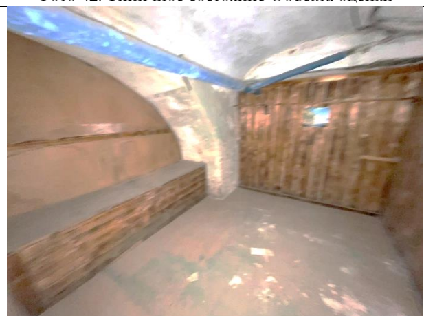
Фото 44. Типичное состояние Объекта оценки
