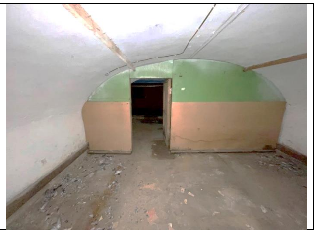
Фото 40. Типичное состояние Объекта оценки
