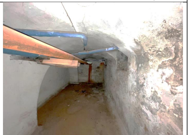
Фото 28. Типичное состояние Объекта оценки
