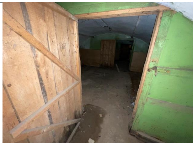
Фото 36. Типичное состояние Объекта оценки
