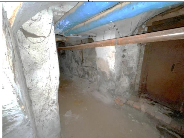
Фото 34. Типичное состояние Объекта оценки
